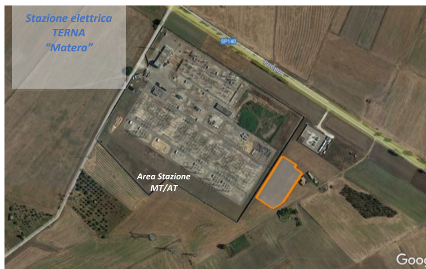
Figura 27. Stazione di elevazione MT/AT e Stazione Terna "Matera"
