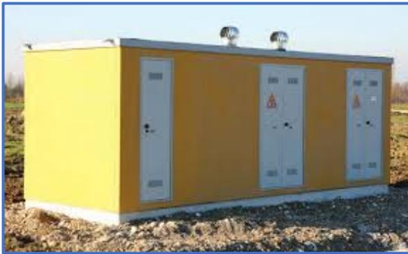
Figura 24: Esempio di monoblocco cabina utente
