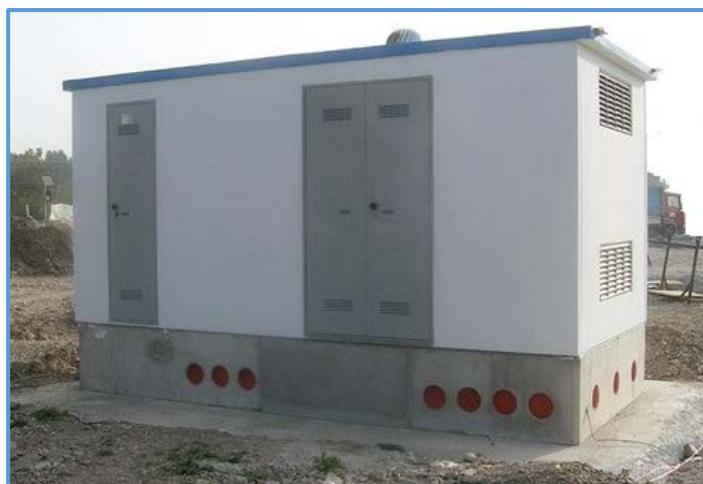
Figura 22: Esempio di monoblocco per la cabina di sezionamento
