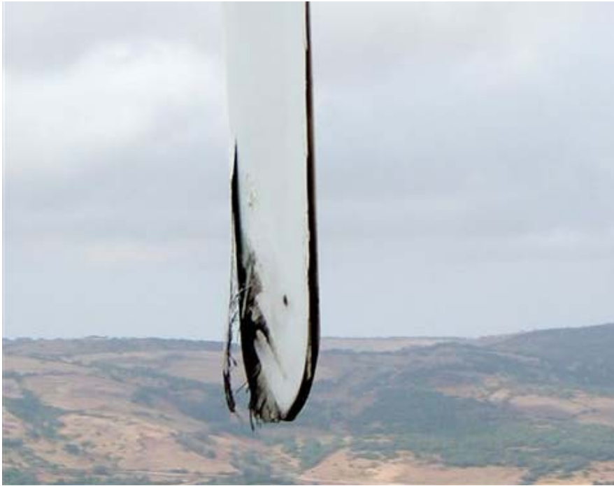
Figura 3: Estremità di pala danneggiata da fulminazione atmosferica
