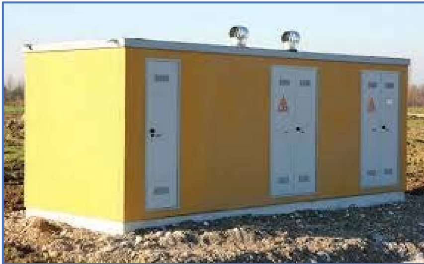
Figura 8: Rappresentazione fotografica di una cabina elettrica prefabbricata tipo
