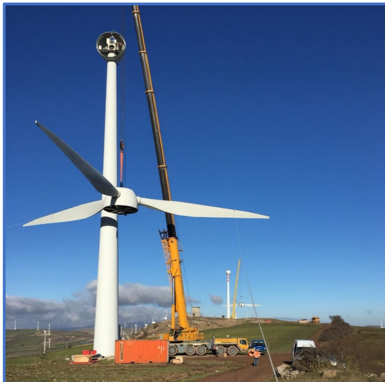
Figura 5: Fase di smontaggio del rotore
