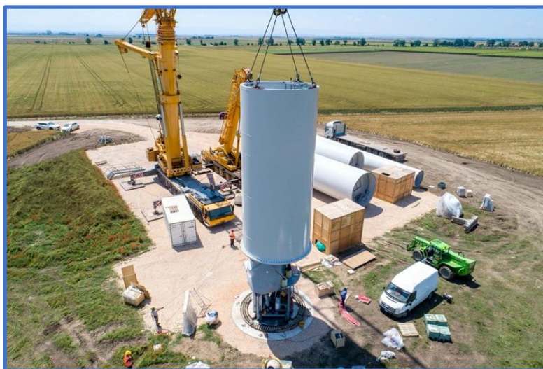
Figura 6: Fase di smontaggio della torre di sostegno
