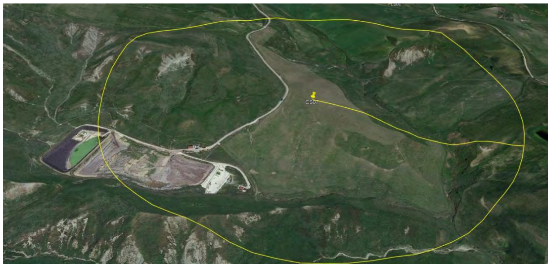
Raggio di 500 m dalla torre CS_07
