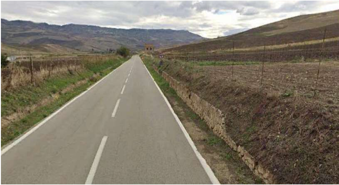
9- report fotografico dello stato di fatto
