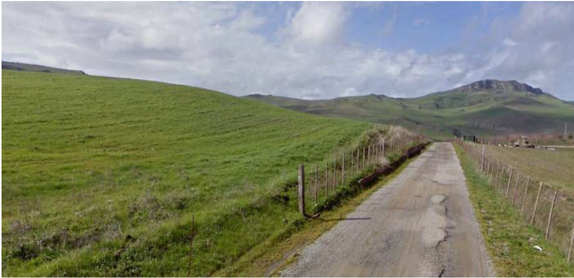
7- report fotografico dello stato di fatto
