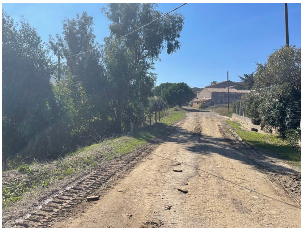
Foto 50 – Panoramica UR 16 (cavidotto interrato)
