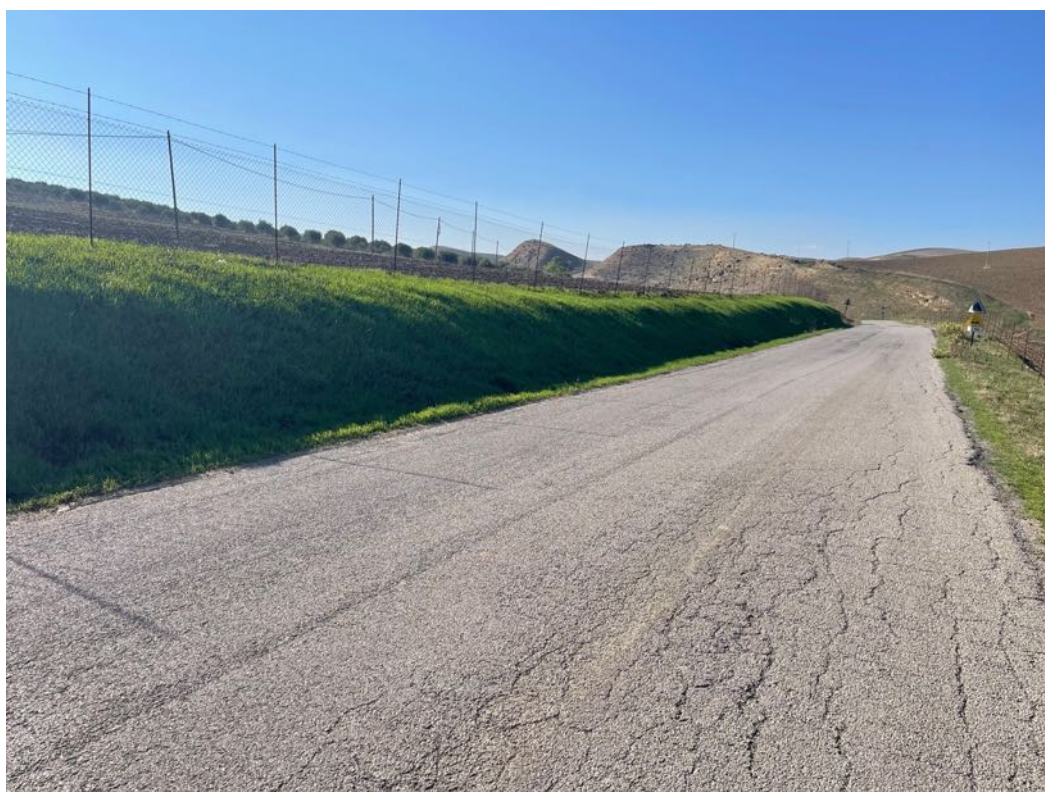
Foto 64 – Panoramica UR 17 (cavidotto interrato)
