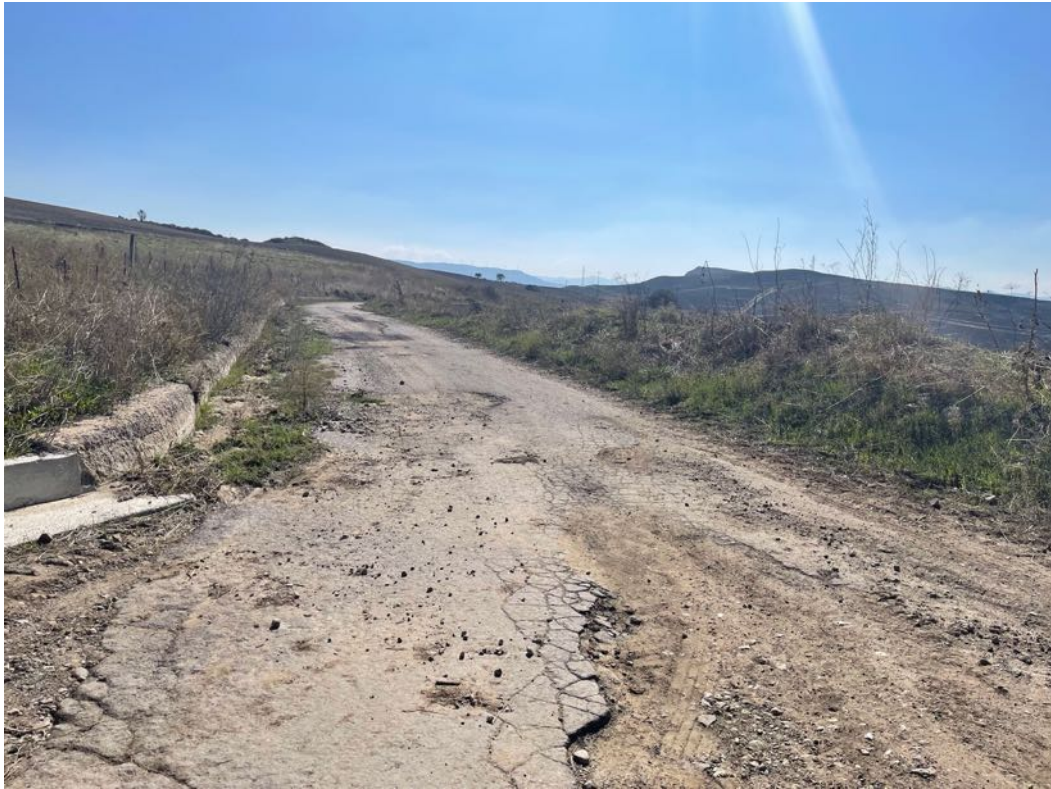
Foto 55 – Panoramica UR 16 (cavidotto interrato)
