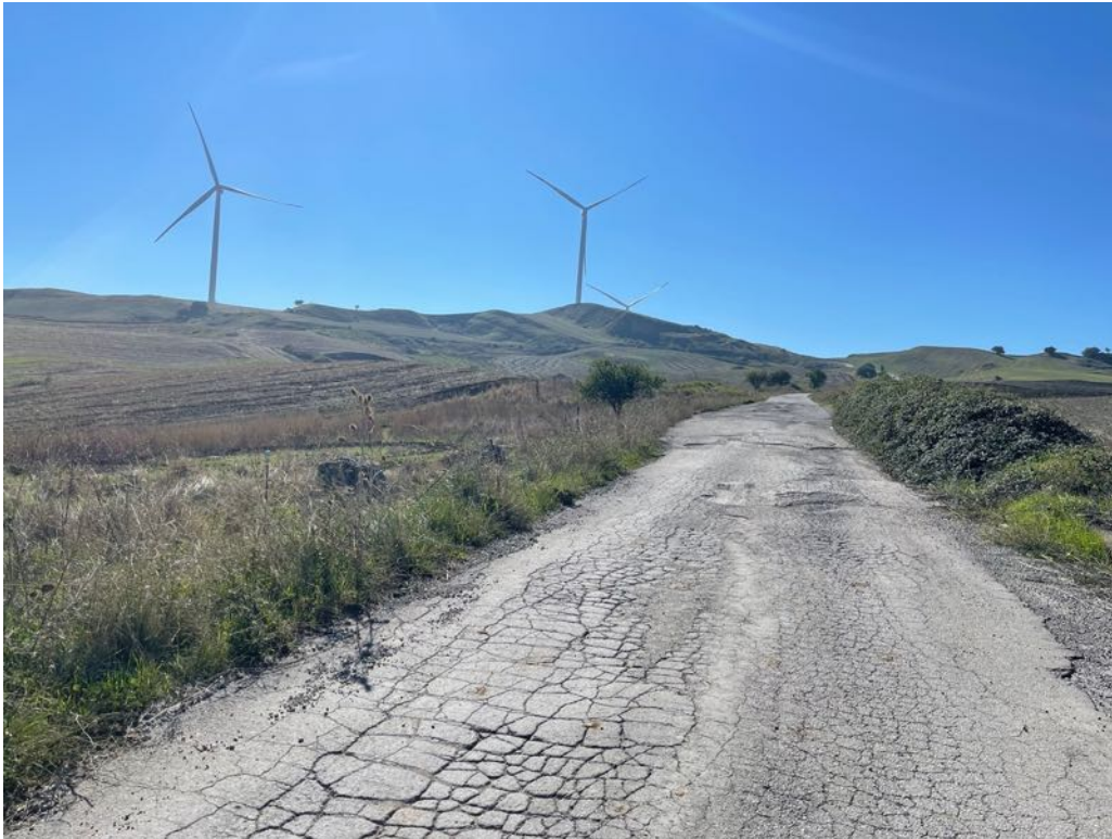
Foto 17 – Panoramica UR 05 (cavidotto interrato)
