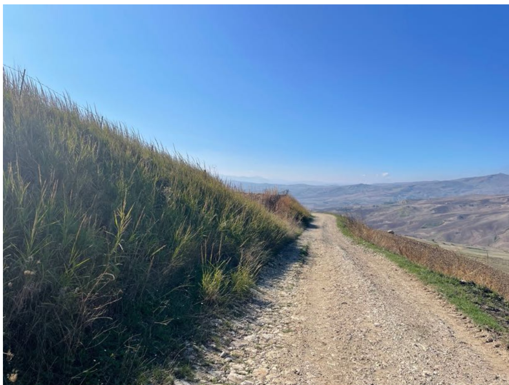
Foto 57 – Panoramica UR 16 (cavidotto interrato)
