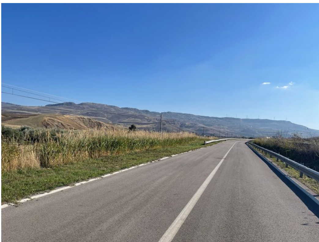
Foto 68 – Panoramica UR 18 (cavidotto interrato)
