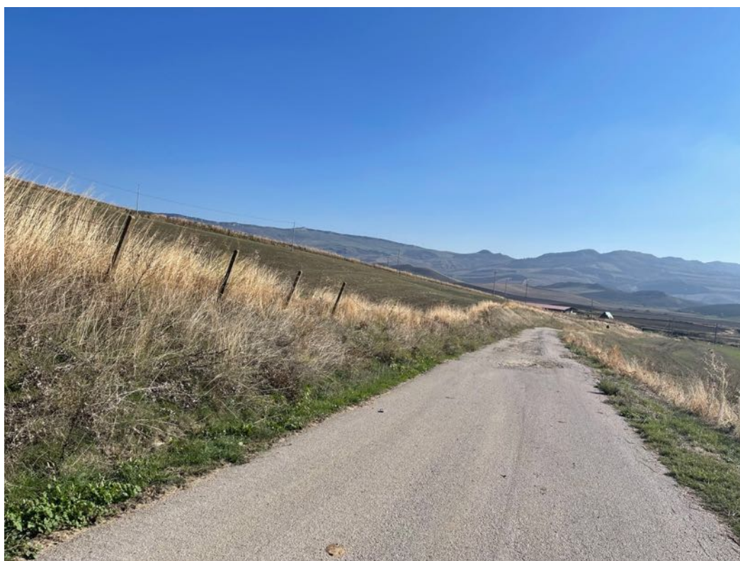
Foto 62 – Panoramica UR 16 (cavidotto interrato)
