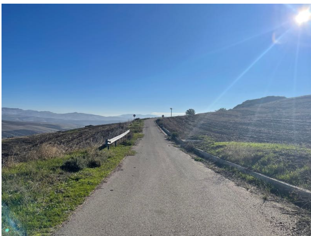
Foto 10 – Panoramica UR 03 (cavidotto interrato)
