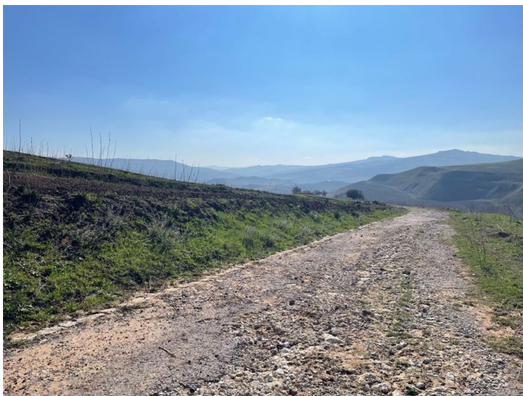
Foto 60 – Panoramica UR 16 (cavidotto interrato)
