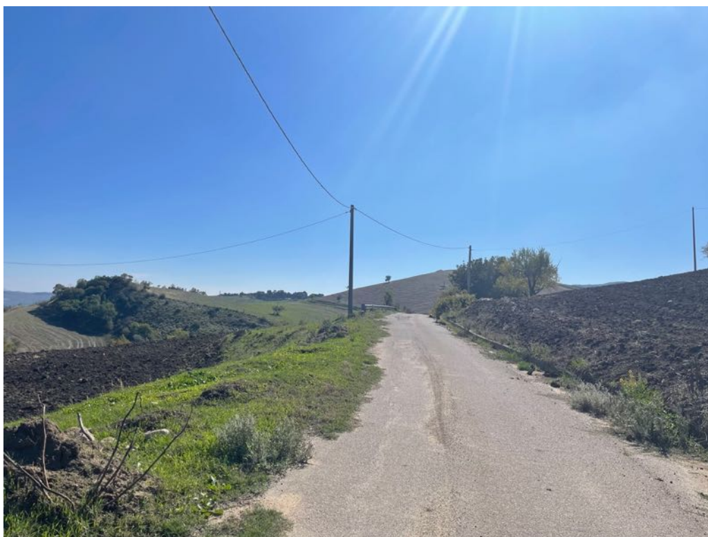
Foto 37 – Panoramica UR 12 (cavidotto interrato)
