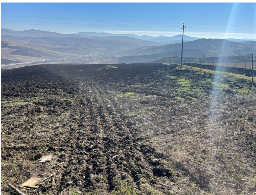
Foto 6 – Panoramica UR 01 (aerogeneratore CS02)
