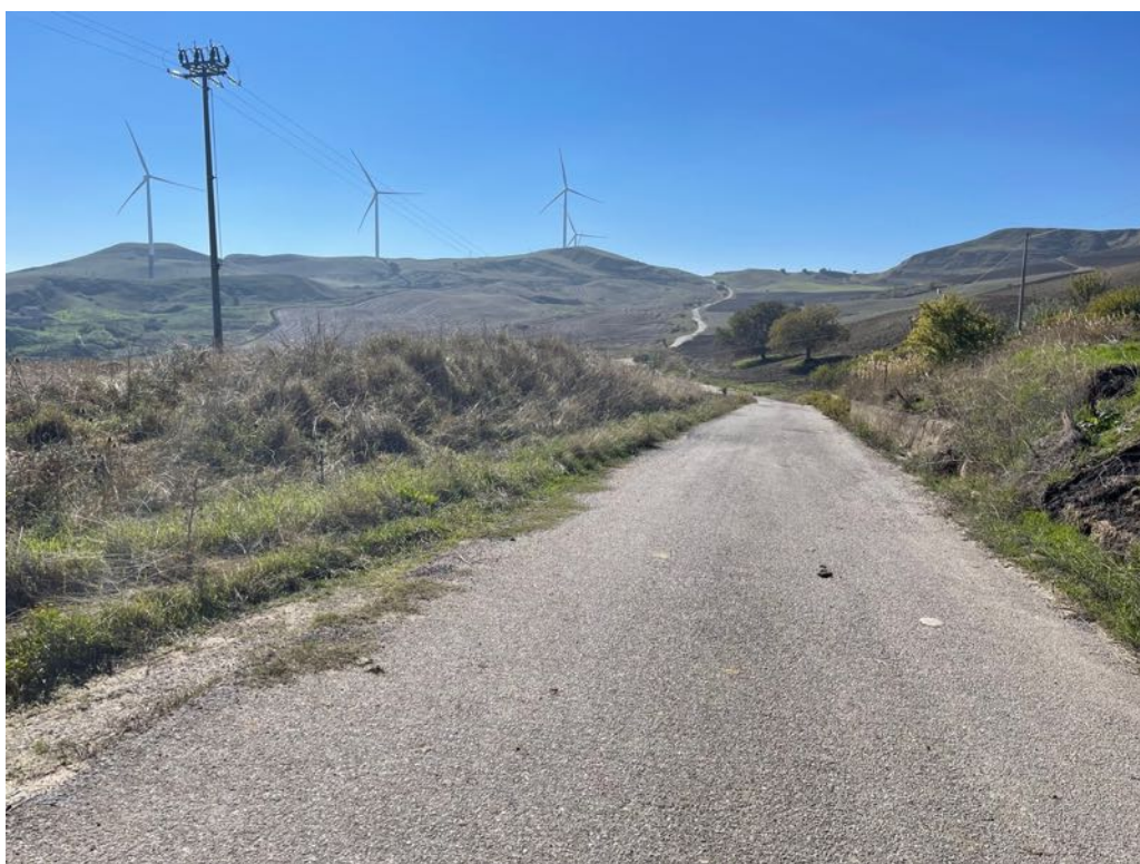
Foto 16 – Panoramica UR 05 (cavidotto interrato)
