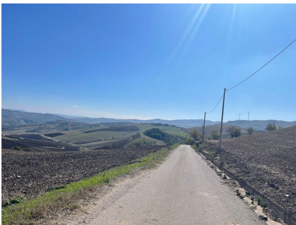
Foto 36 – Panoramica UR 12 (cavidotto interrato)
