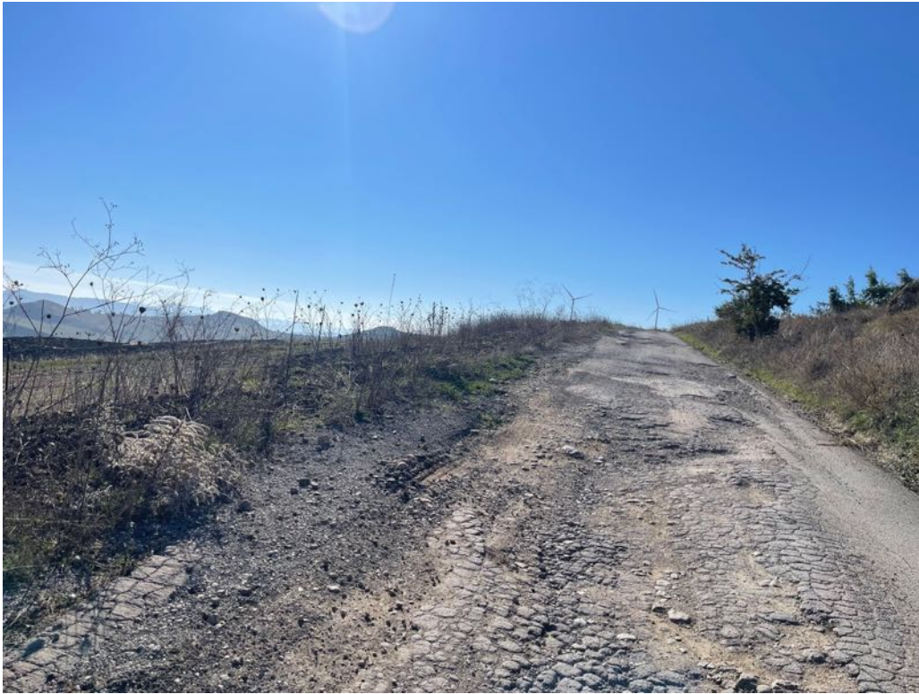
Foto 11 – Panoramica UR 03 (cavidotto interrato)
