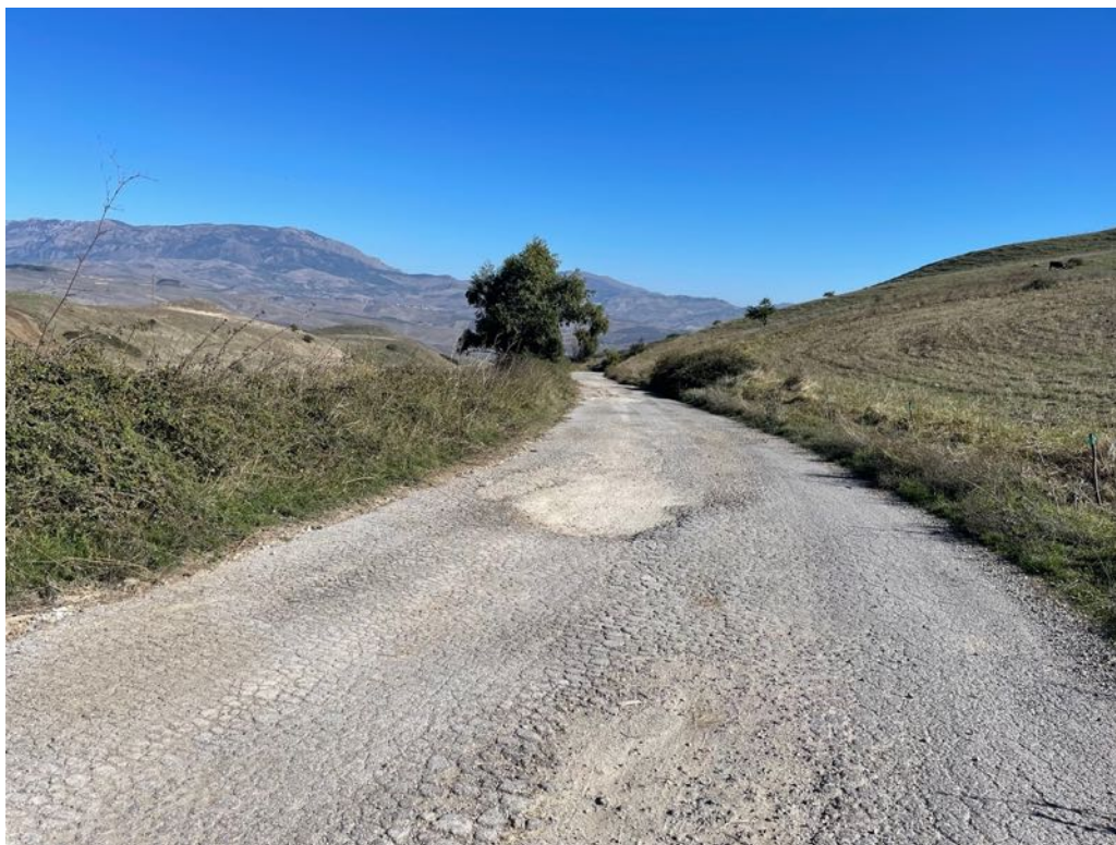
Foto 19 – Panoramica UR 05 (cavidotto interrato)
