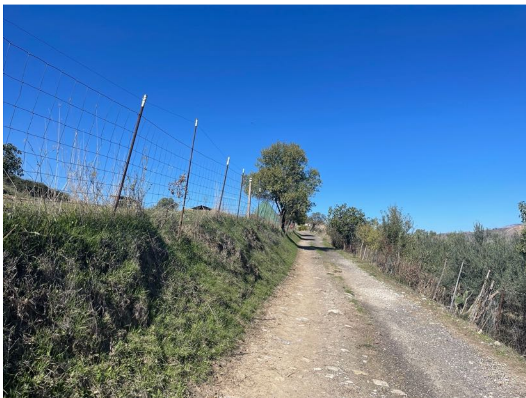
Foto 45 – Panoramica UR 14 (cavidotto interrato)
