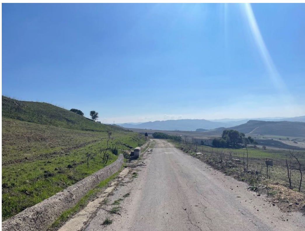
Foto 54 – Panoramica UR 16 (cavidotto interrato)
