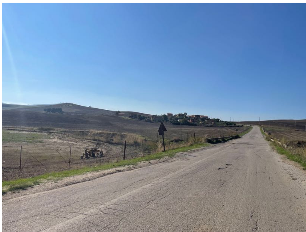
Foto 63 – Panoramica UR 17 (cavidotto interrato)
