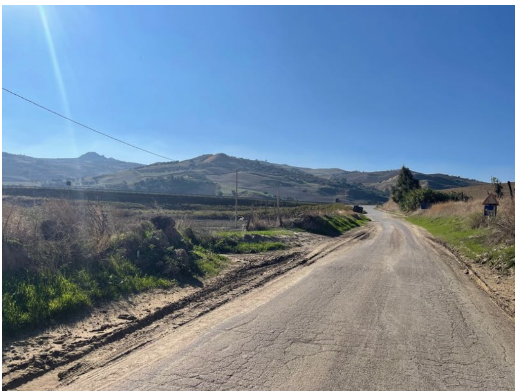
Foto 66 – Panoramica UR 17 (cavidotto interrato)
