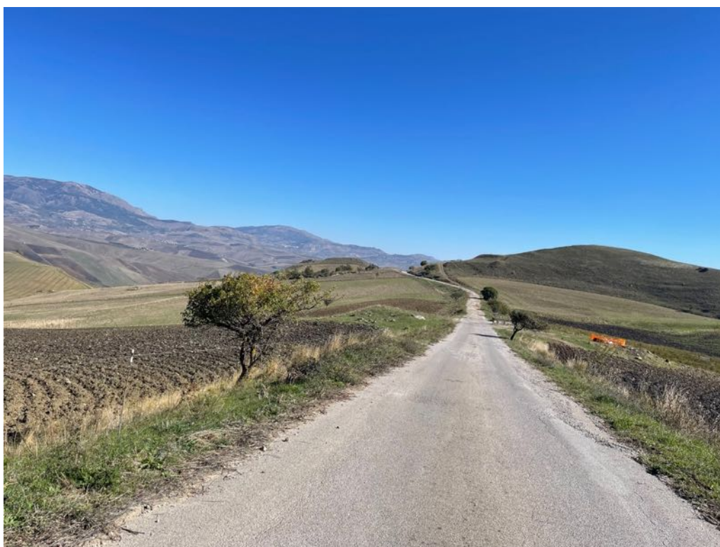
Foto 20 – Panoramica UR 05 (cavidotto interrato)
