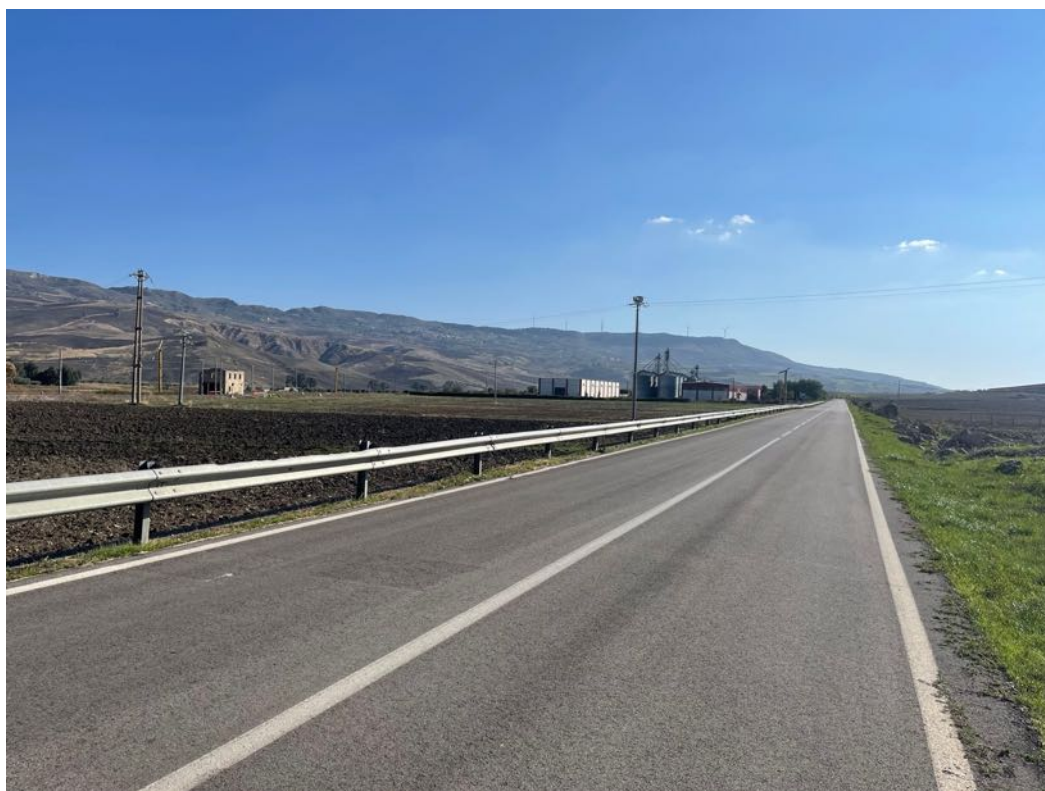
Foto 69 – Panoramica UR 18 (cavidotto interrato)
