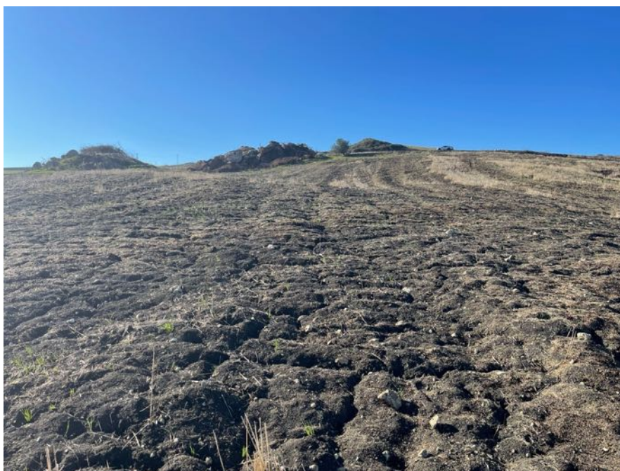
Foto 2 – Panoramica UR 01 (aerogeneratore CS01)
