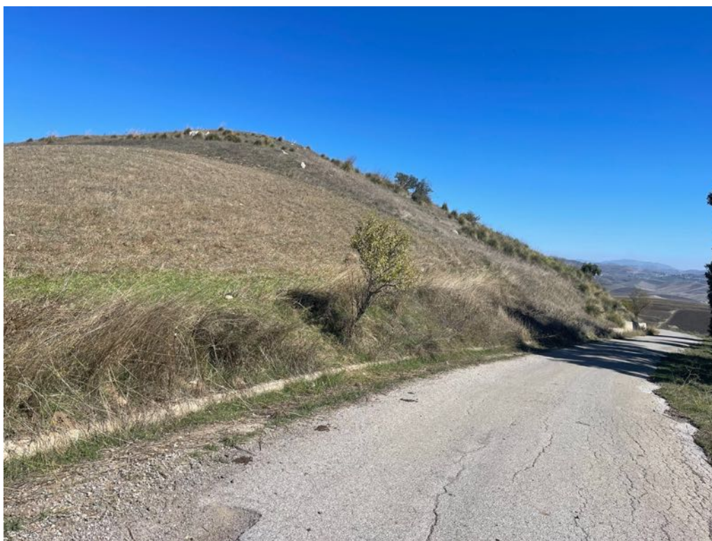
Foto 35 – Panoramica UR 12 (cavidotto interrato)
