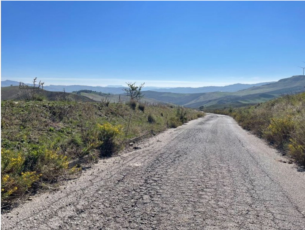
Foto 29 – Panoramica UR 09 (cavidotto interrato)
