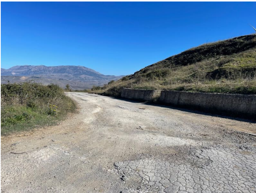
Foto 18 – Panoramica UR 05 (cavidotto interrato)
