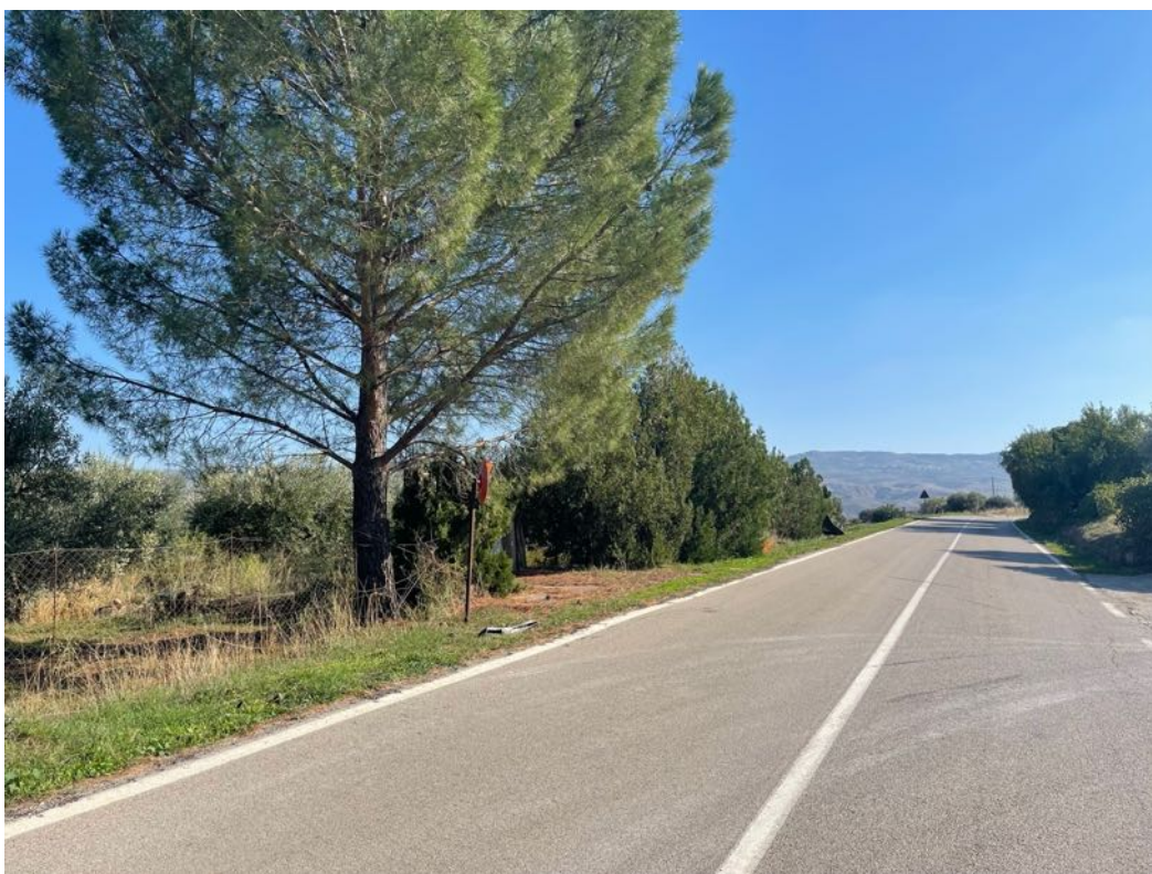
Foto 67 – Panoramica UR 18 (cavidotto interrato)
