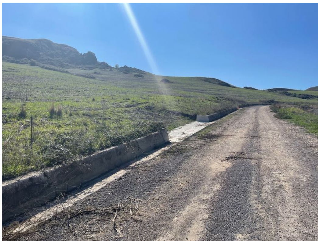
Foto 53 – Panoramica UR 16 (cavidotto interrato)
