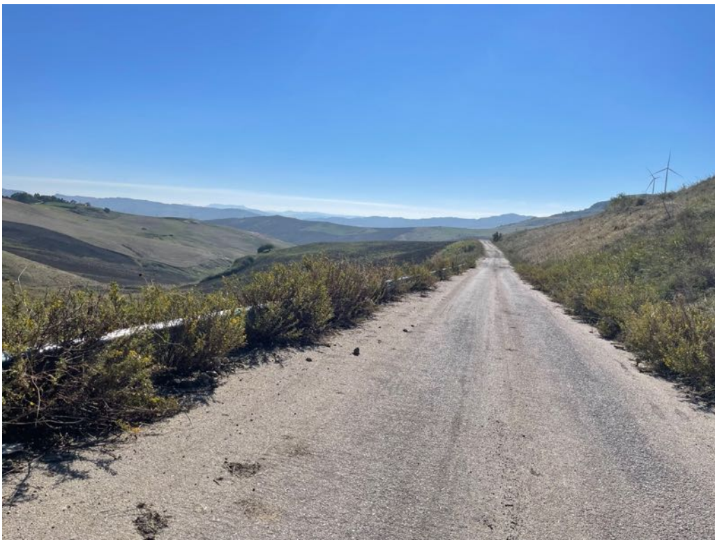
Foto 30 – Panoramica UR 09 (cavidotto interrato)
