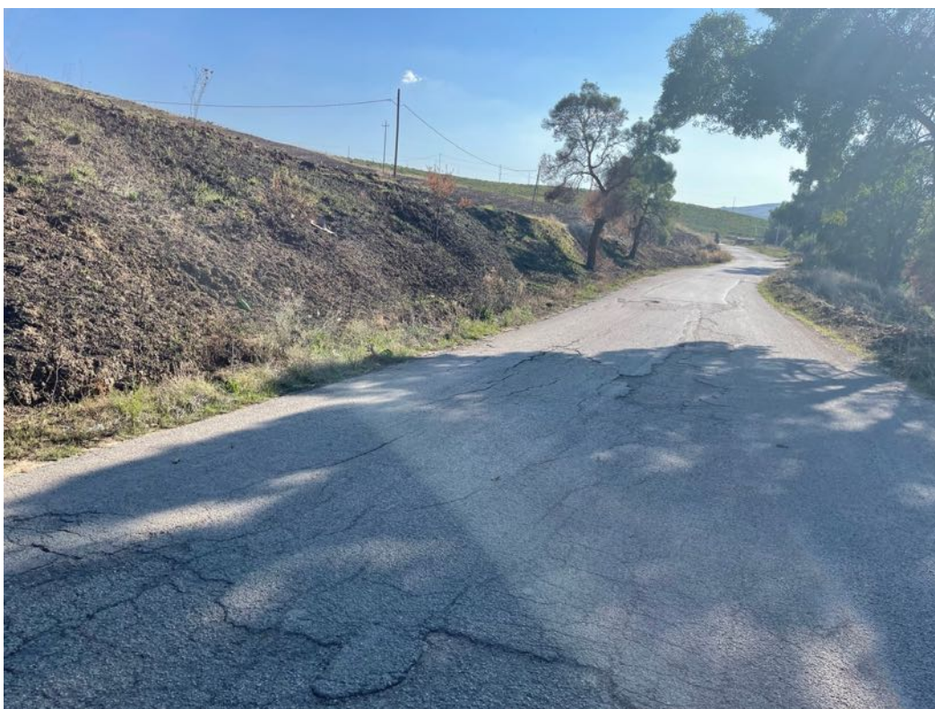
Foto 65 – Panoramica UR 17 (cavidotto interrato)
