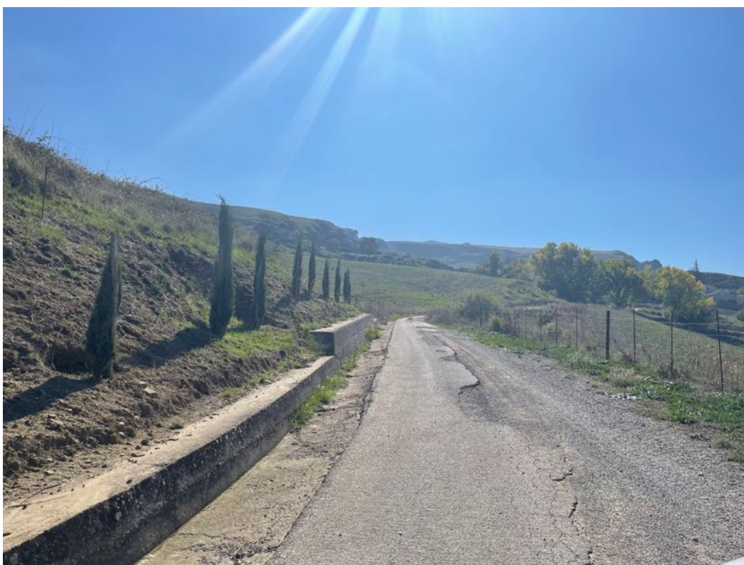
Foto 52 – Panoramica UR 16 (cavidotto interrato)
