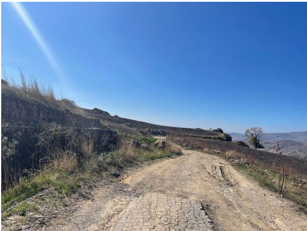
Foto 56 – Panoramica UR 16 (cavidotto interrato)
