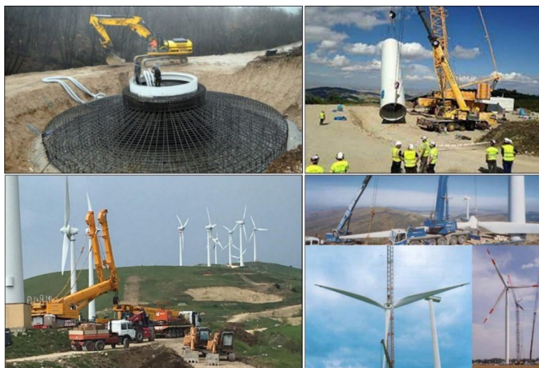
Alcune fasi di cantiere per la realizzazione di un Impianto eolico (Fonte: web)
