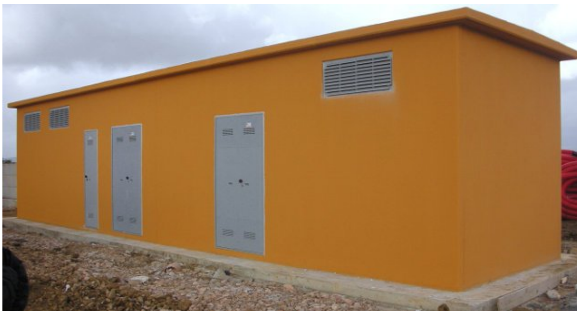
Fig.5 Posizionamento di una delle cabine elettriche
