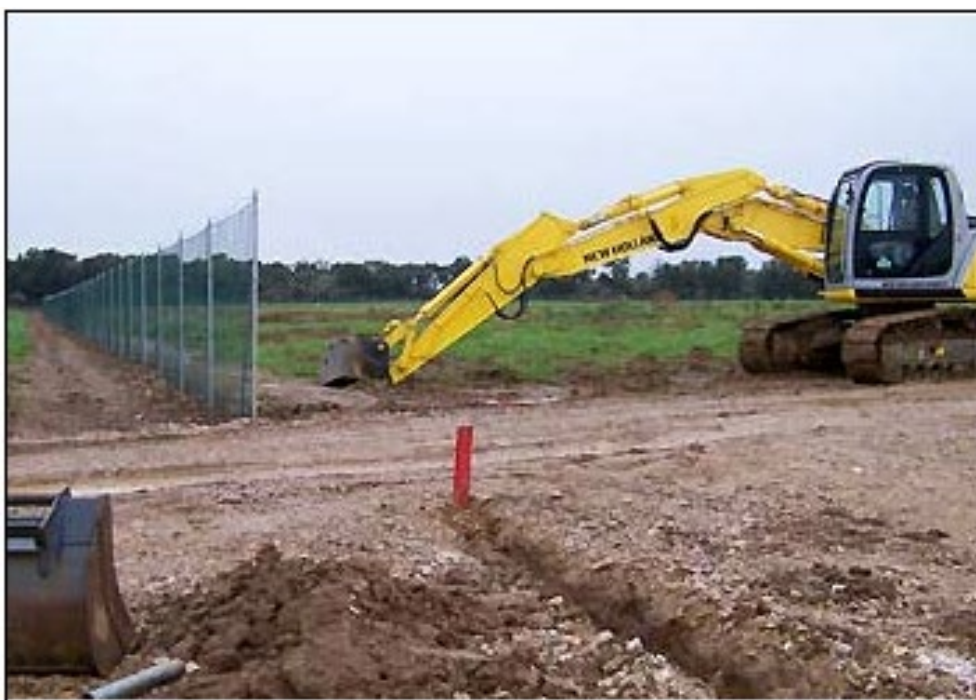
Fig. 5 Predisposizione della recinzione del parco fotovoltaico
