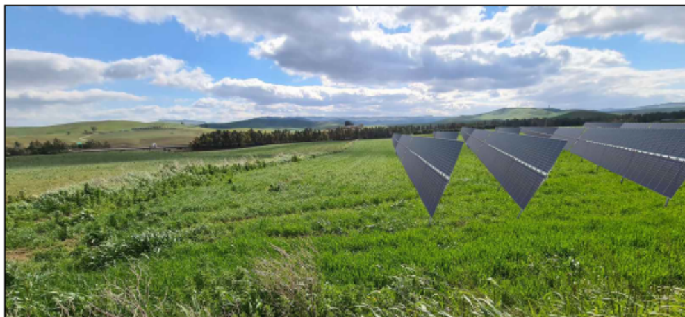
FOTO: STATO POST OPERAM
