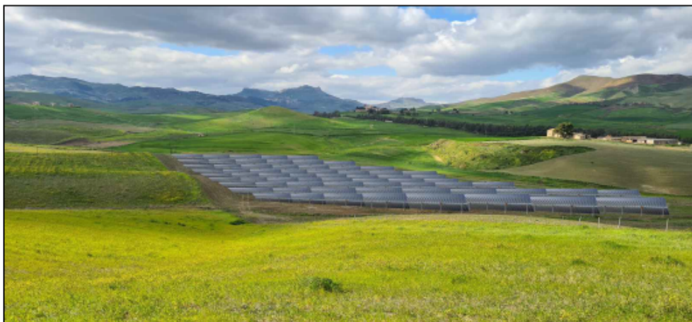
FOTO2: STATO POST OPERAM
