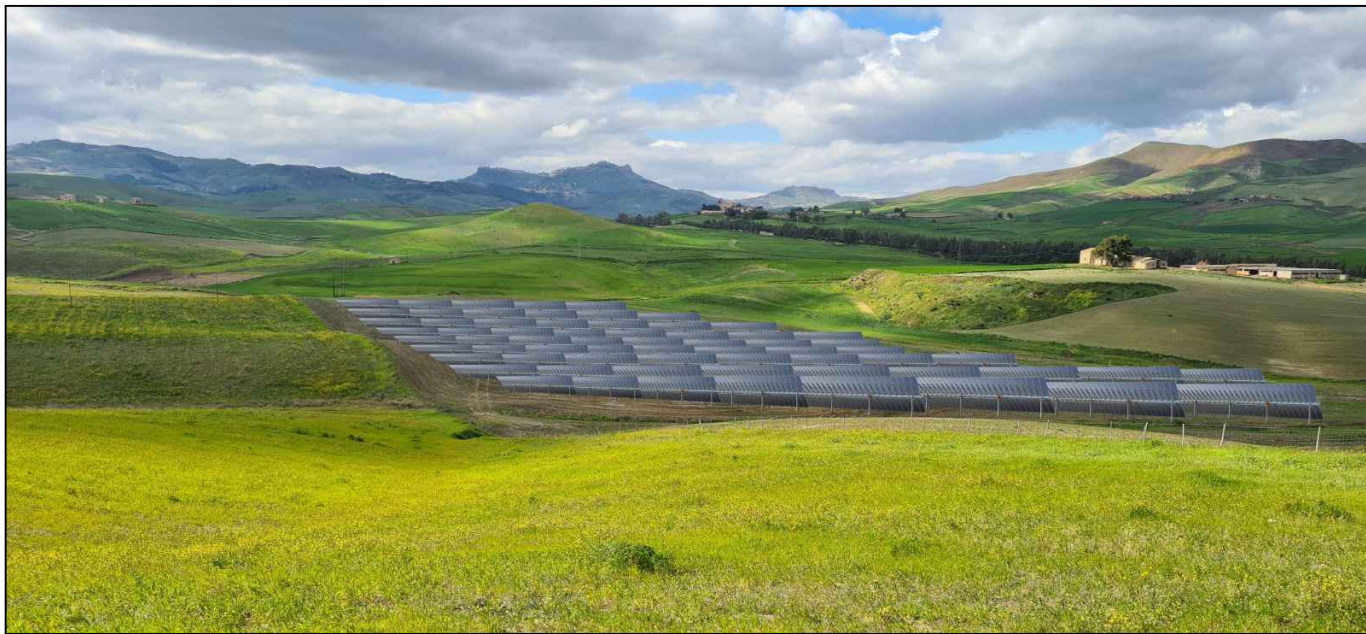
FOTO2: STATO POST OPERAM:
