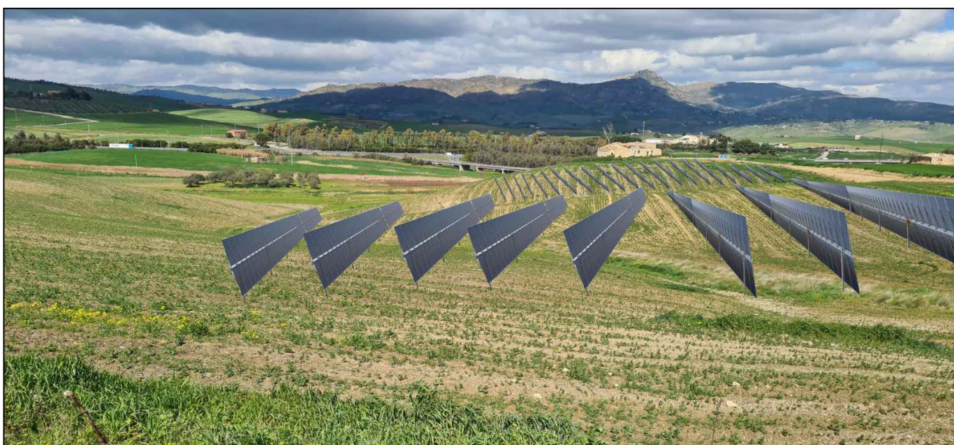
FOTO2: STATO POST OPERAM:
