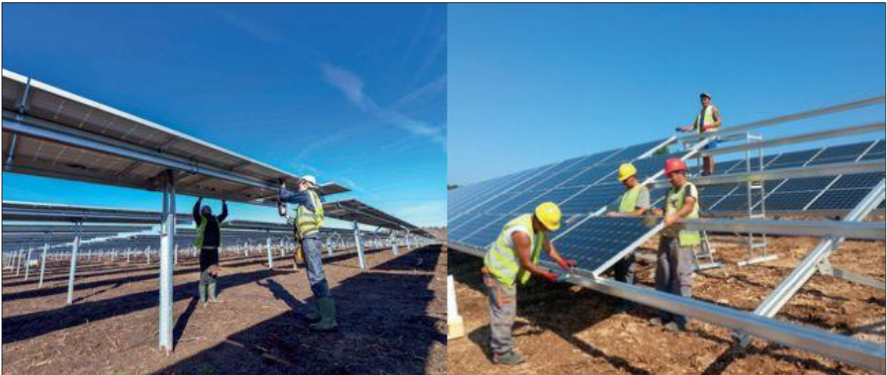
Figura 24: Montaggio tracker e moduli fotovoltaici
