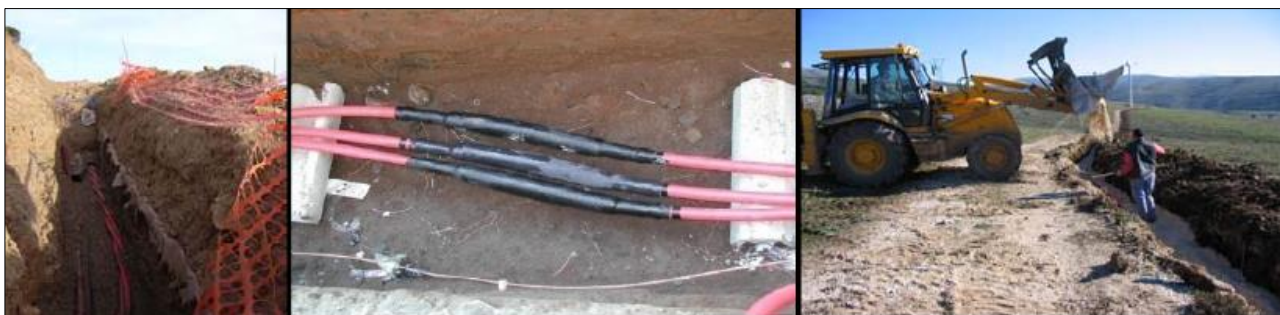
Figura 25: Scavo con posa cavi
