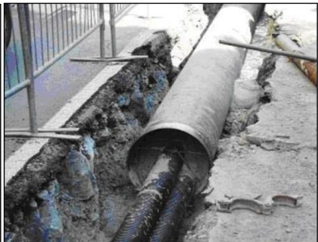
Figura 21: Cavidotto in tubi di acciaio
