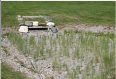
Depressione d'infiltrazione accanto al bacino di ritenzione
