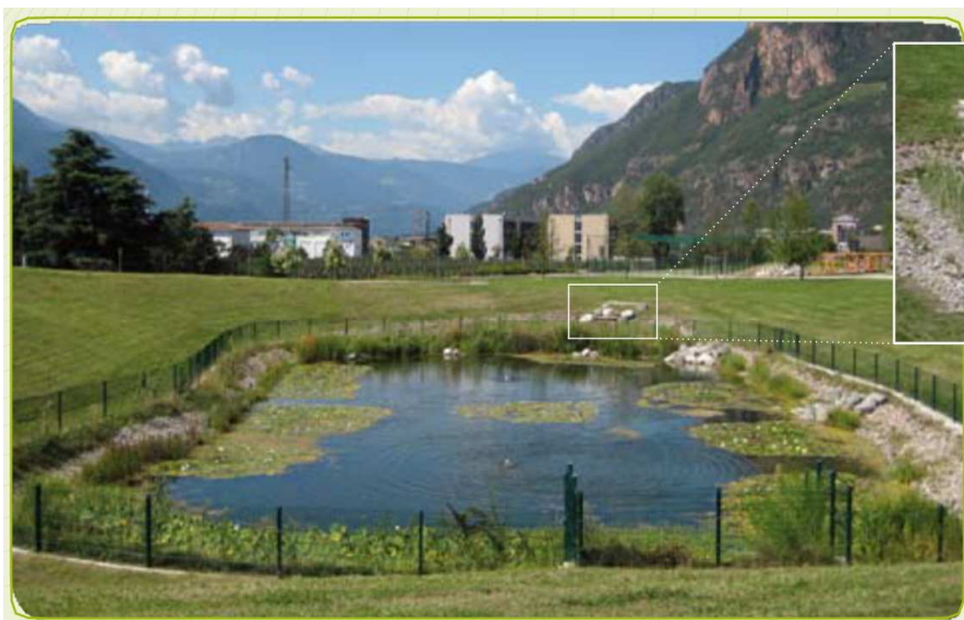
Depressione d'infiltrazione accanto al bacino di ritenzione
