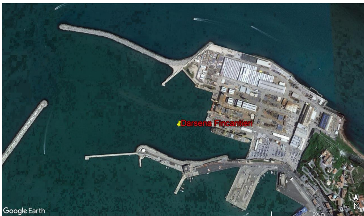
Figura 1. Darsena Fincantieri del Porto di Ancona. Immagine presa da Google Earth.
