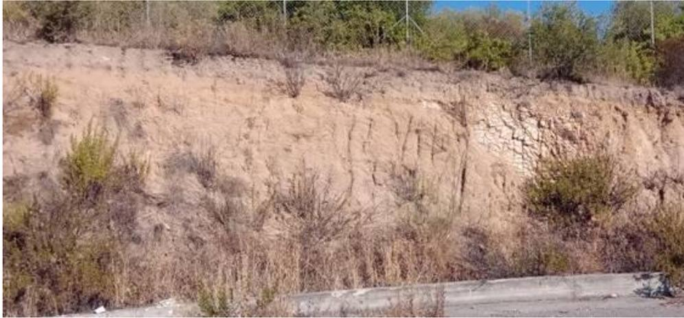
**Figura 18 - Esempio di cappellaccio di alterazione ben visibile nel taglio stradale (Olbia, via Caltanissetta). Il materiale si autosostiene senza supporto alcuno lungo il taglio stradale ad alto angolo e sono ancora riconoscibili cristalli, tessitura magmatica e superfici secondarie quali clivaggi e fratture. Si nota nel lato destro la presenza di un filoncello leucogranitico. Da ultimo, si distingue un terreno superficiale eluvio colluviale grigio a tetto dell'affioramento.**
