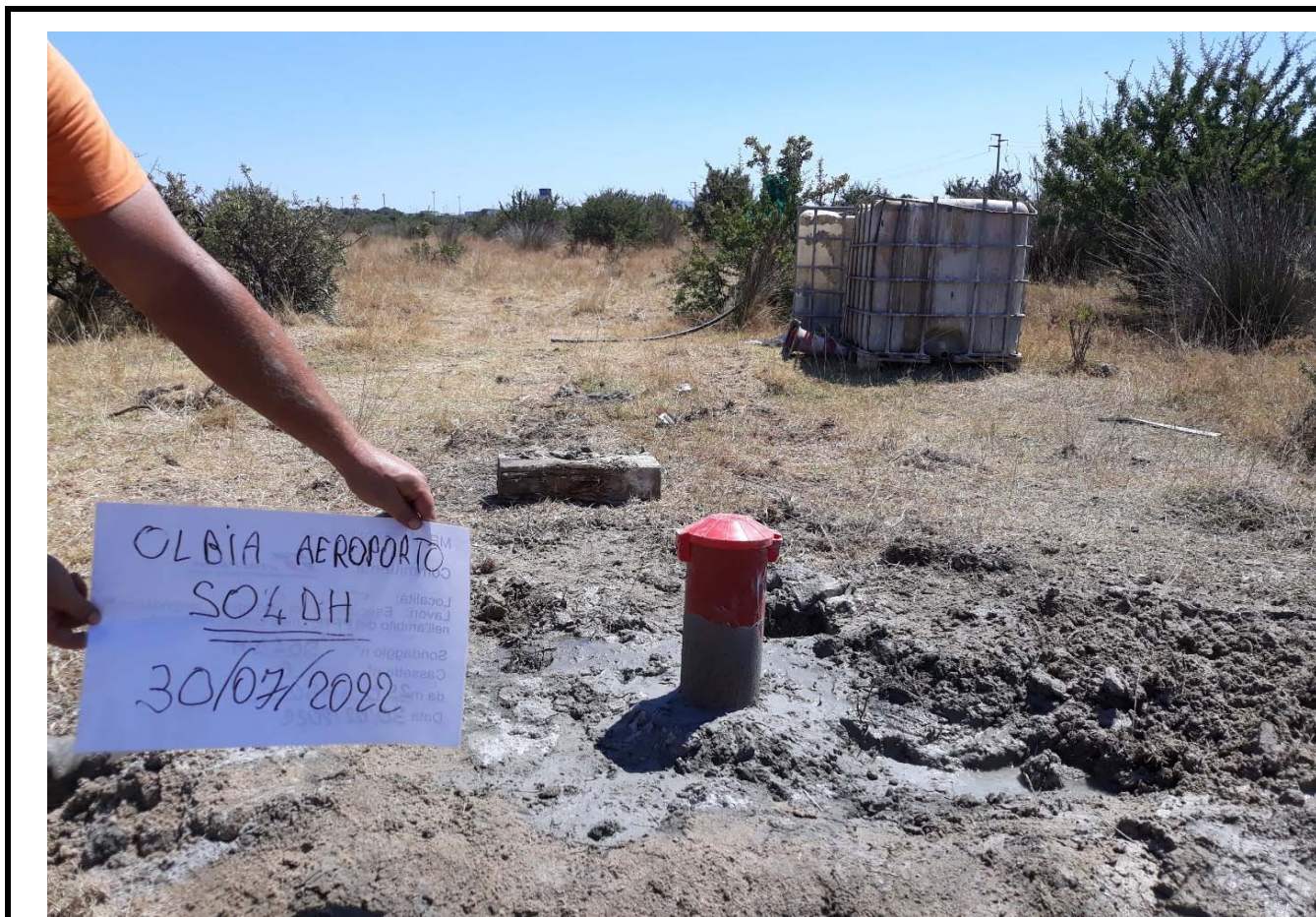
Sondaggio n° S04 DH Installazione pozzetto in PVC
