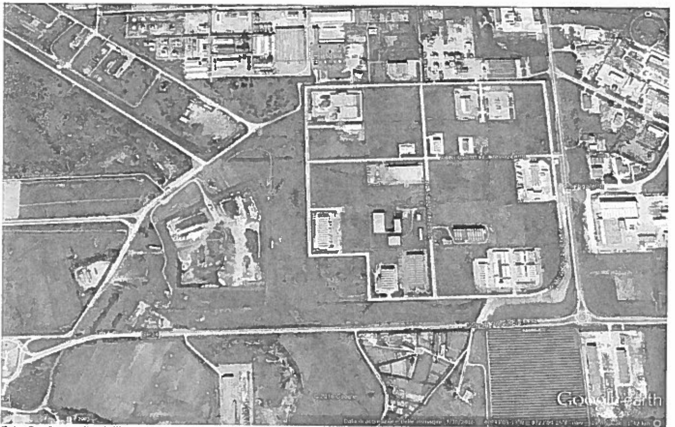
Foto 2 - Dettaglio dell'impianto di discarica
