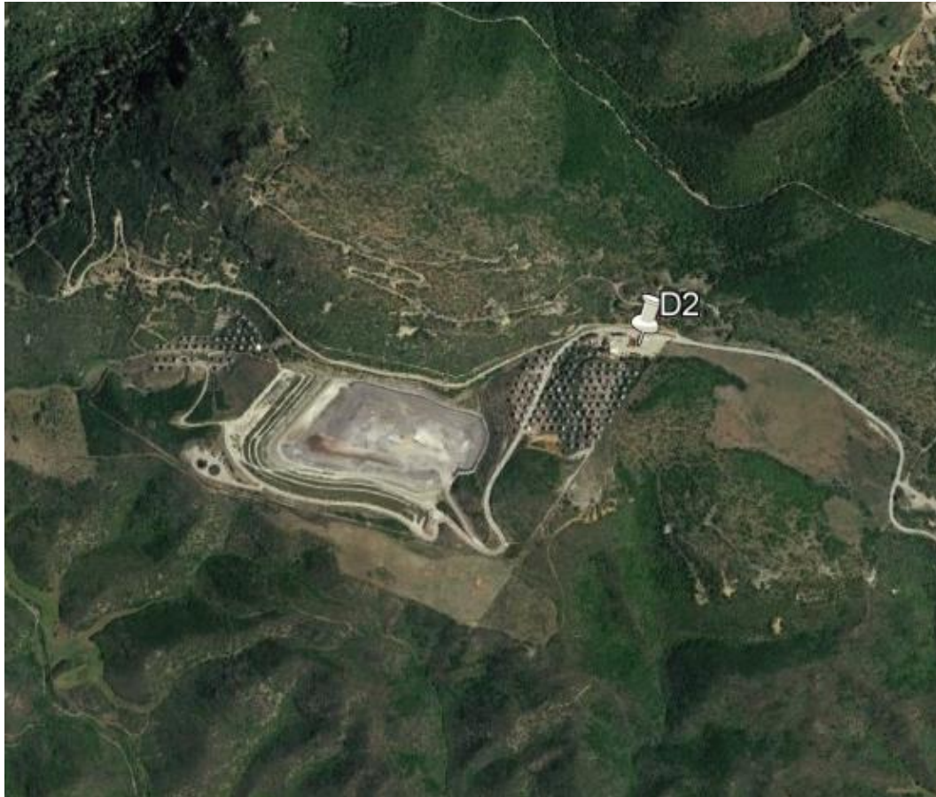
Figura 3-7 - RIVERSO SPA, foto aerea
