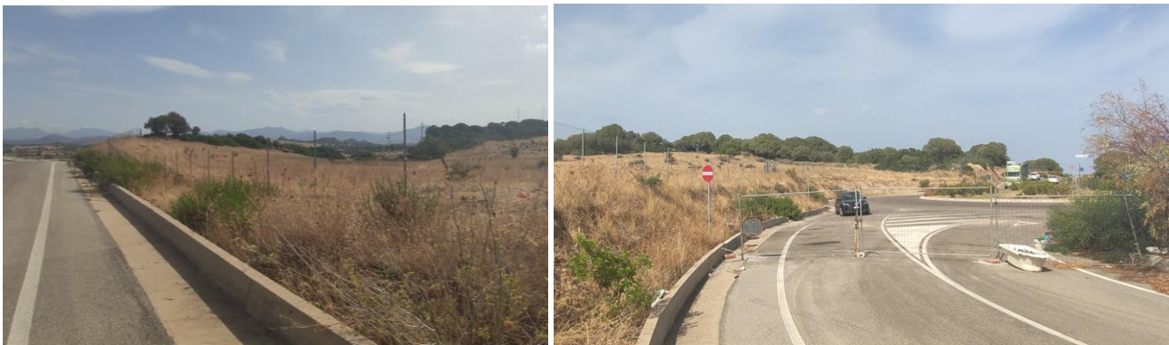
Figura 8.25 - Foto dell'accesso all'area di cantiere da via Caltanissetta e ramo viabilità chiuso al traffico presente in corrispondenza della rotonda su Via Caltanissetta
