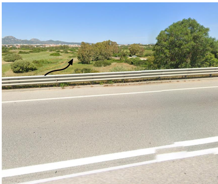
Figura 8.45 - Foto dell'accesso all'area di cantiere da Panoramica/via Ortos
