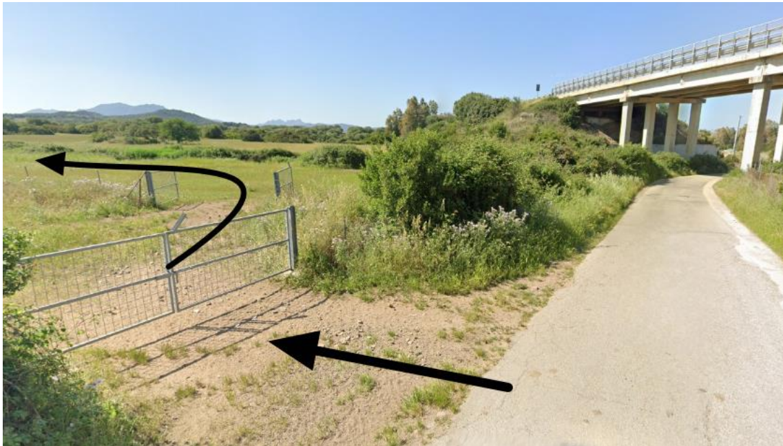
Figura 8.47 - Foto dell'accesso all'area di cantiere tramite pista di cantiere a partire da via Siena .
