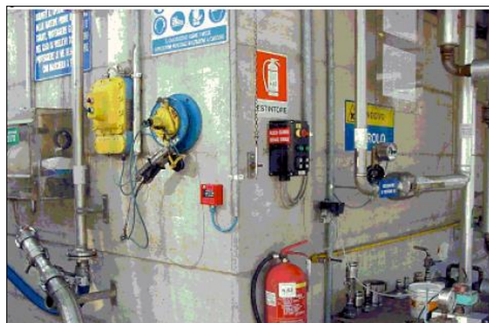
Il pulsante P09 per avviamento impianto a diluvio in zona pompe di scarico stirolo si trova sul muro adiacente la postazione di scarico
