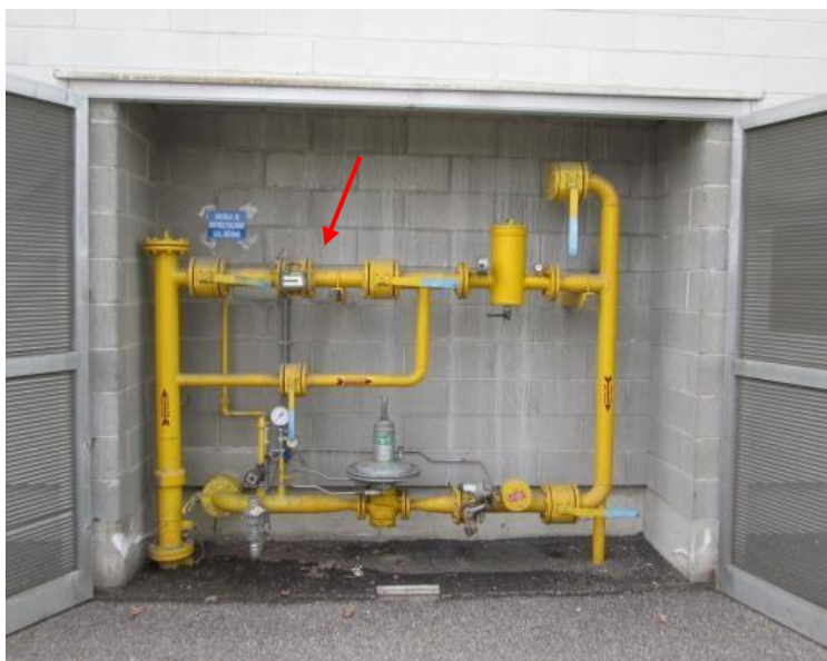
Intercettazione metano (fabbricato 3401 lato ovest)
