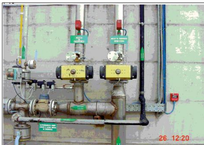
Il pulsante P10 per avviamento impianto a diluvio serbatoio B5 si trova sul muro sud del bacino B5
