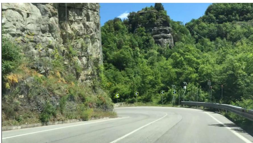
Curva a 90° alla progressiva Km 1 + 265,00 – sezione n°57
