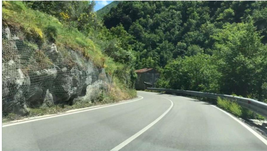
Tratta tra le sezioni n° 77 e sezione n° 83 - edificio a valle
