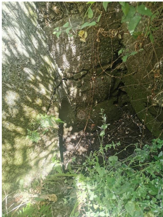
Foto 4: Tubo in calcestruzzo a sezione circolare in prossimità dell'interferenza TOC 5.
