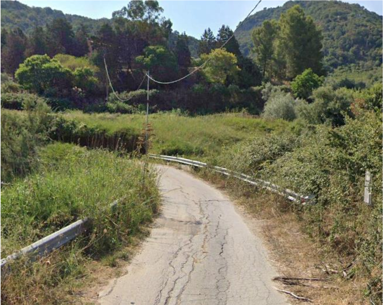
Foto 1: Opera di attraversamento in corrispondenza del torrente Canace (Coordinate: 499343.163 m E, 4214134.671 m N)
