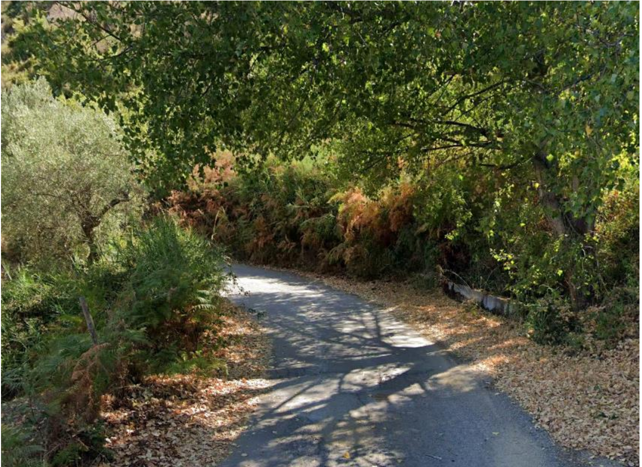
Foto 2: Opera di attraversamento in corrispondenza della viabilità esistente (Coordinate: 499716.167 m E, 4214101.030 m N)
