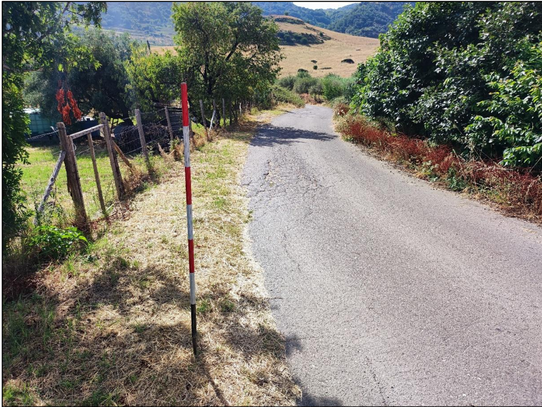
Fig. 16: strada senza denominazione. Parte iniziale del cavidotto
