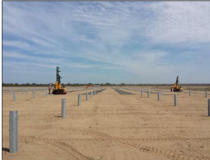
Fig. 7: esempio di posizionamento delle strutture tramite l'infissione di pali
