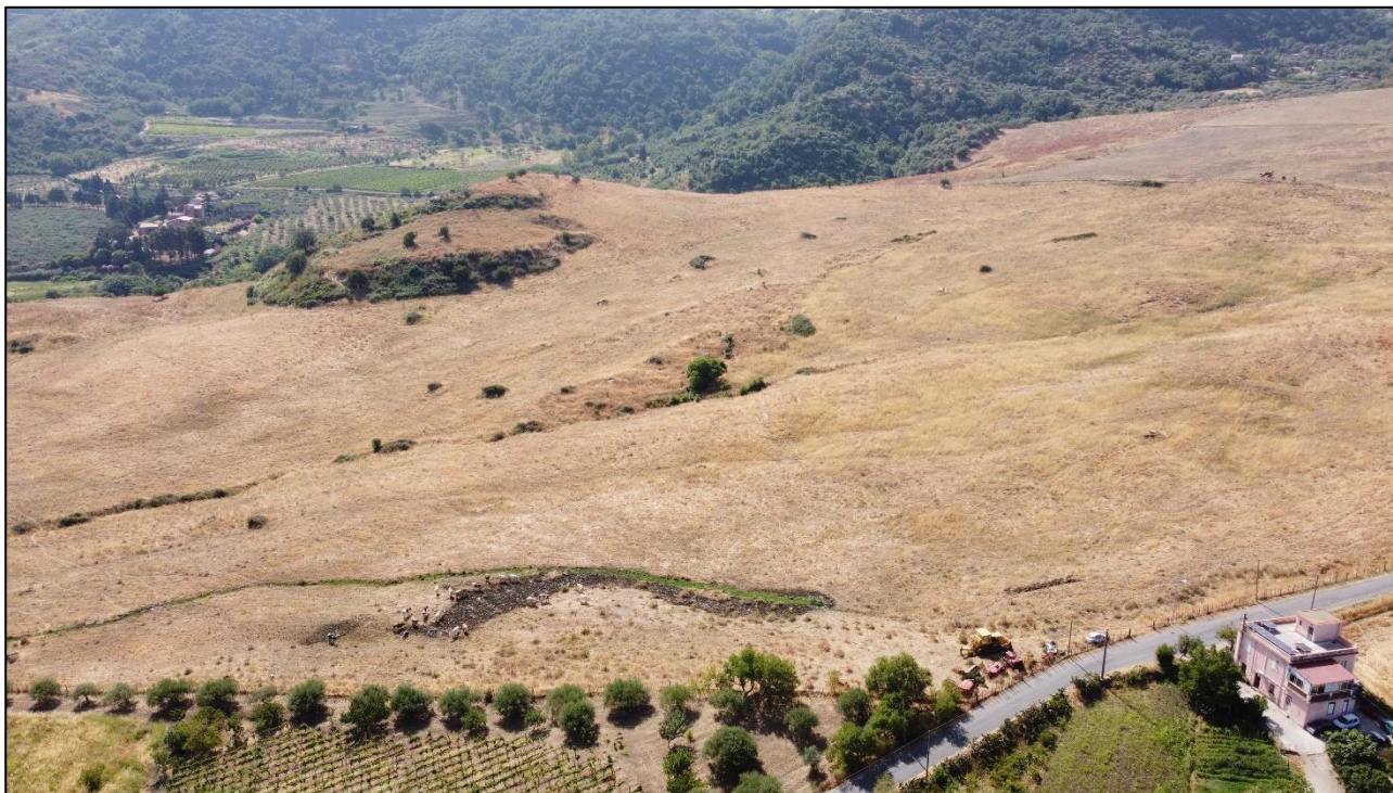
Fig. 21: vista da drone dell'impianto 3 (UR 3)
