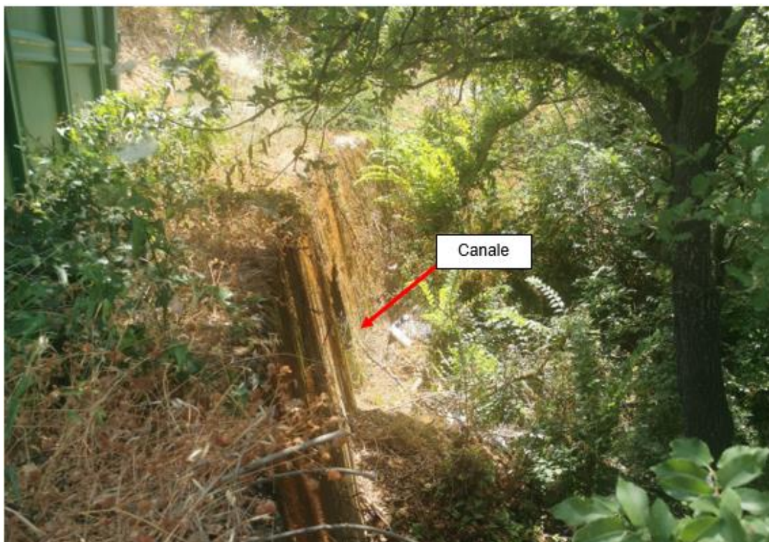
Figura 22: Canale sul quale verrà effettuato l'attraversamento in TOC del cavidotto MT 30 kV
