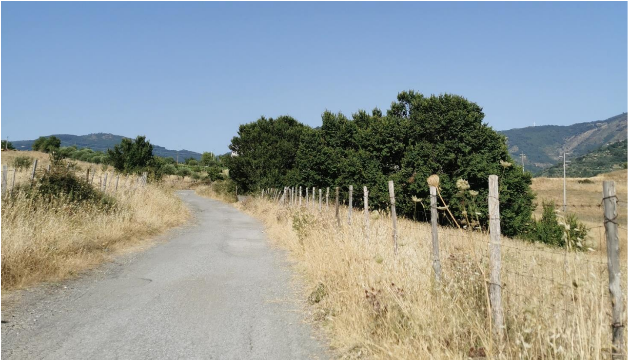
Figura 28: Punto di vista PV22: vista sulla strada dove è prevista la realizzazione del cavidotto MT 30 kV di impianto (coordinate 499015.00 m E 4214173.00 m N)
