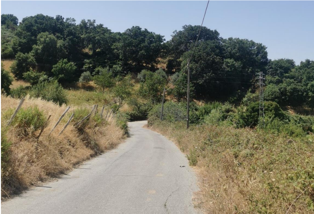
Figura 9: Punto di vista PV7: vista sulla strada dove è prevista la realizzazione del cavidotto MT 30 kV di impianto (coordinate 501007.00 m E 4216042.00 m N)
