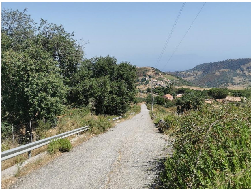
Figura 5: Punto di vista PV3: vista sulla strada dove è prevista la realizzazione del cavidotto MT 30 kV di impianto (coordinate 501188.00 m E 4215326.00 m N)
