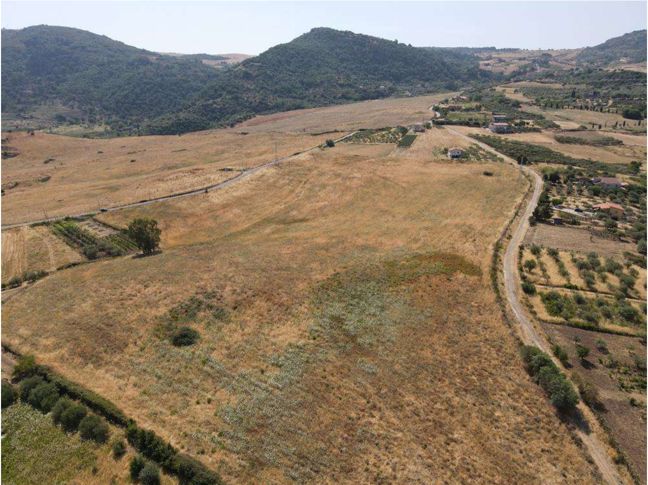
Figura 85: Foto area di impianto 4
