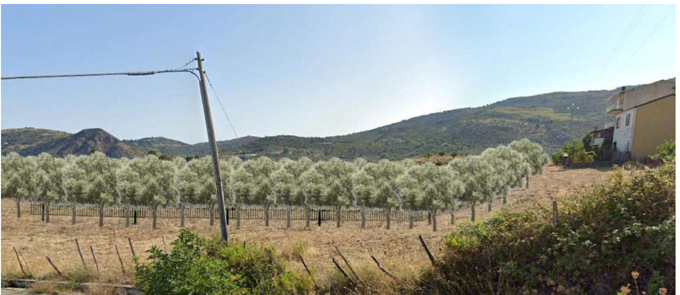
Figura 179: Vista post-operam realizzazione impianto
