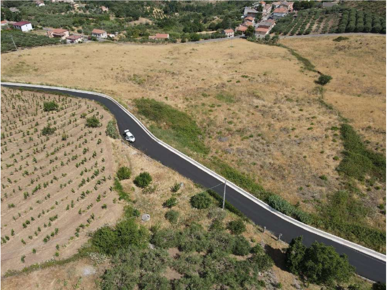
Figura 93: Foto area di impianto 5
