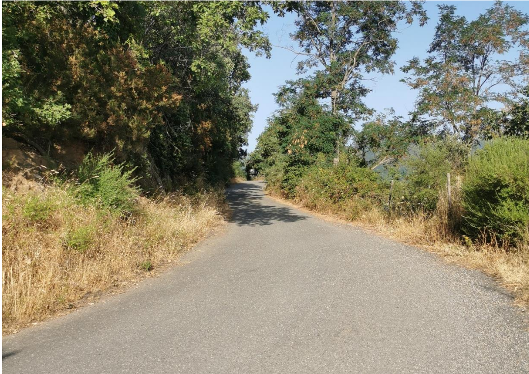
Figura 57: Punto di vista PV15: vista sulla strada dove è prevista la realizzazione del cavidotto MT 30 kV di impianto (coordinate 499863.00 m E 4215436.00 m N)
