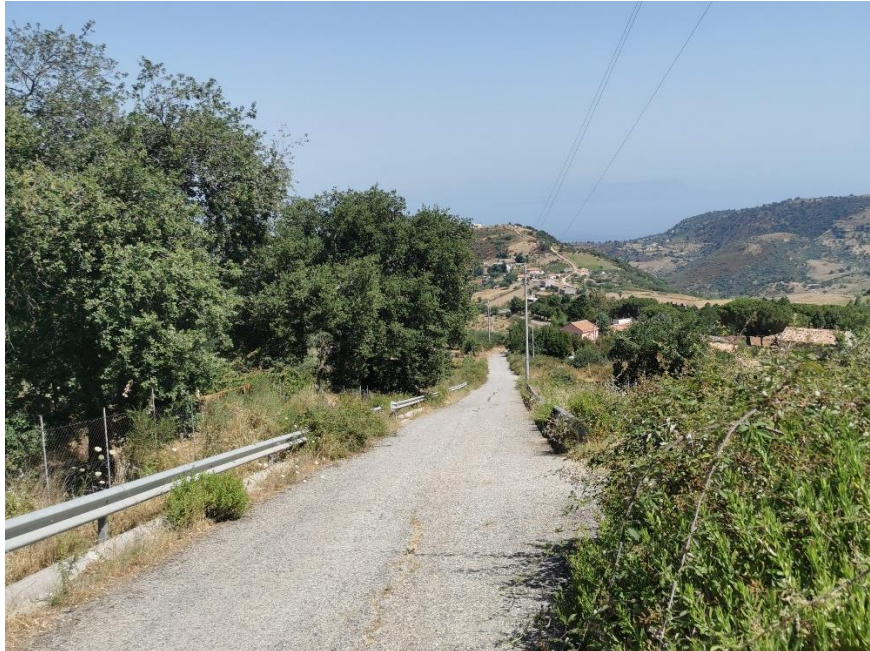
Figura 43: Punto di vista PV3: vista sulla strada dove è prevista la realizzazione del cavidotto MT 30 kV di impianto (coordinate 501188.00 m E 4215326.00 m N)
