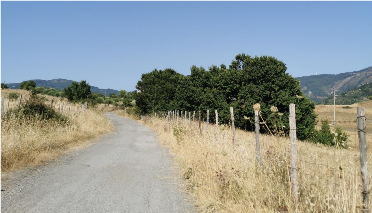
Figura 66: Punto di vista PV22: vista sulla strada dove è prevista la realizzazione del cavidotto MT 30 kV di impianto (coordinate 499015.00 m E 4214173.00 m N)
