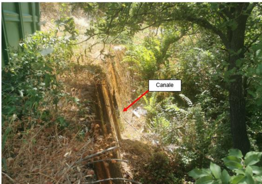
Figura 60: Canale sul quale verrà effettuato l'attraversamento in TOC del cavidotto MT 30 kV relativo al Punto di vista PV17
