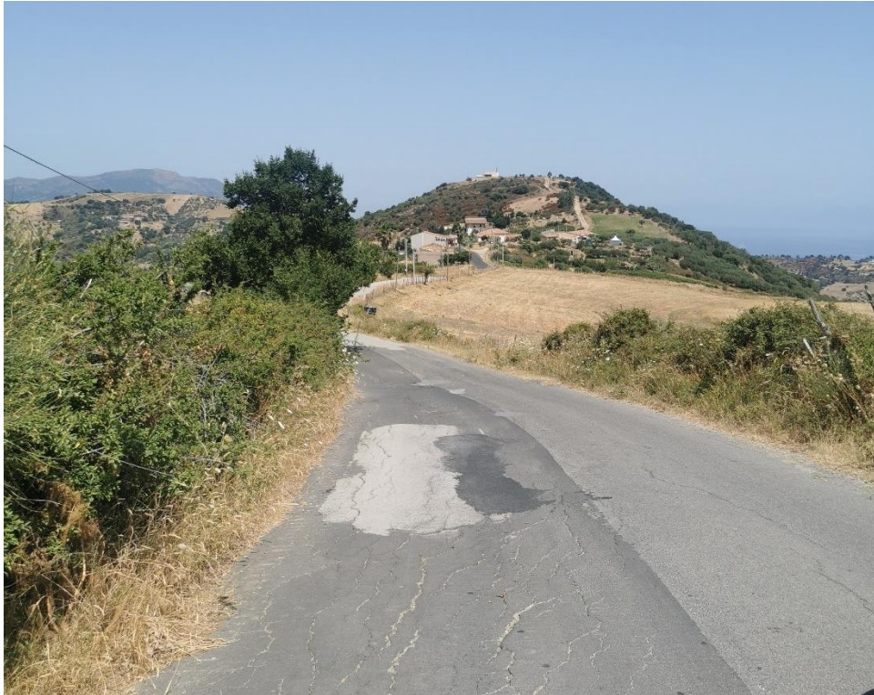
Figura 45: Punto di vista PV5: vista sulla strada dove è prevista la realizzazione del cavidotto MT 30 kV di impianto (coordinate 501218.00 m E 4215856.00 m N)
