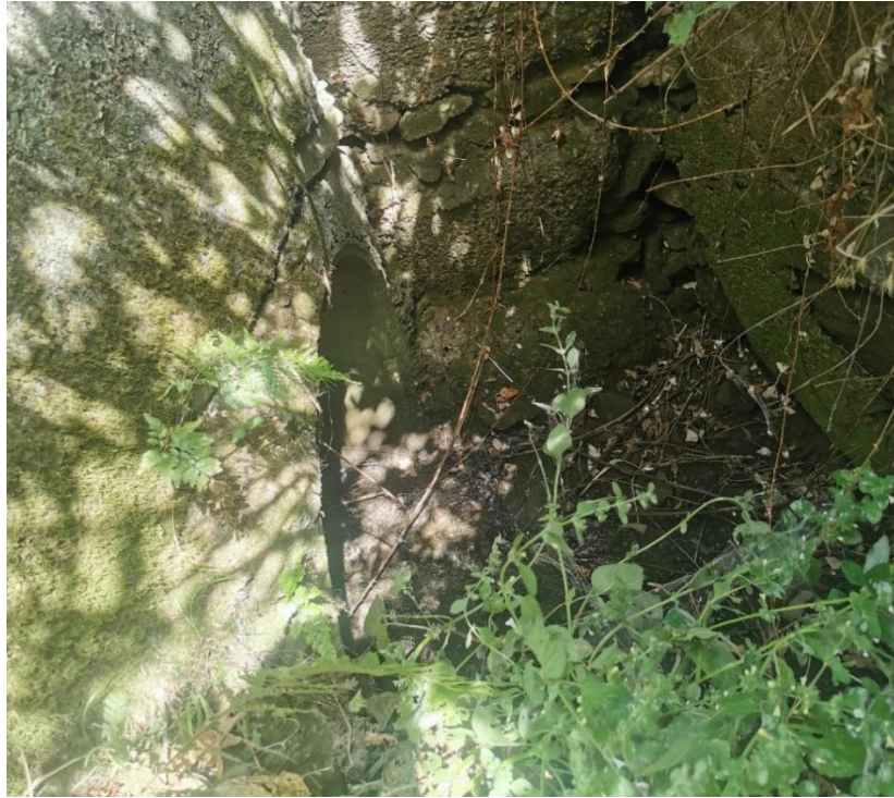
Figura 51: Canale sul quale verrà effettuato l'attraversamento in TOC del cavidotto MT 30 kV relativo al Punto di vista PV10
