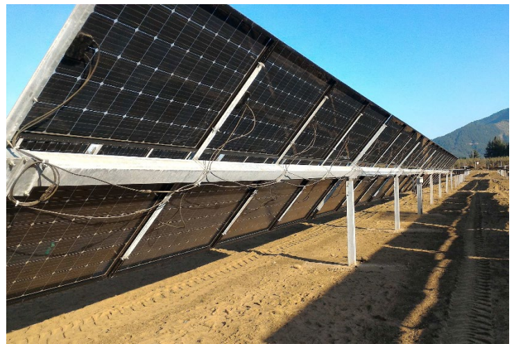
Fig.3 Predisposizione dei pali e ancoraggio delle strutture in acciaio di sostegno ai moduli fotovoltaici
