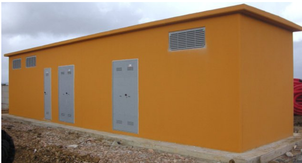
Fig.5 Posizionamento di una delle cabine elettriche
