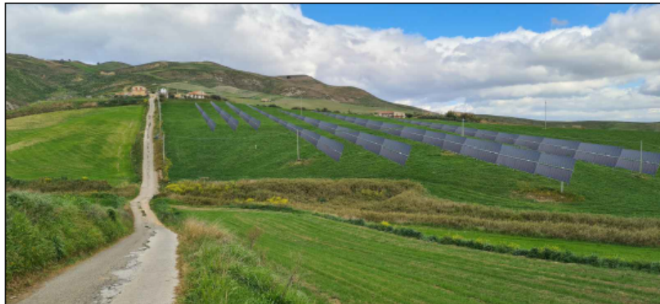
FOTO: STATO POST OPERAM
