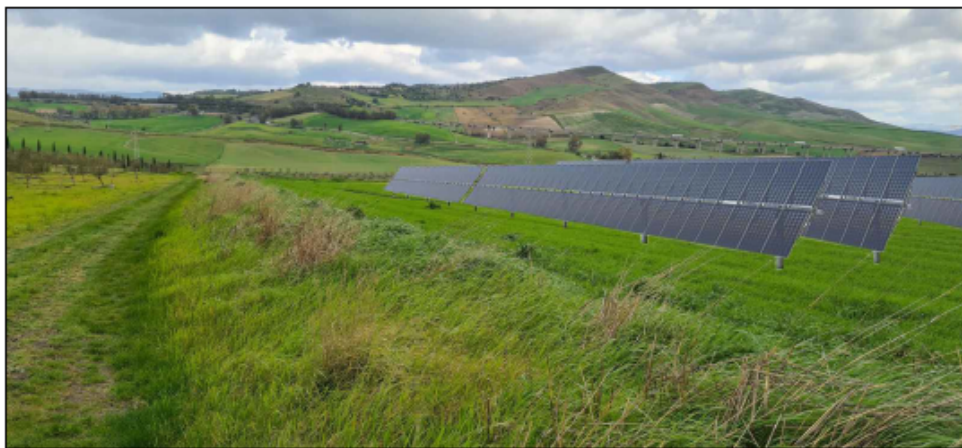
FOTO2: STATO POST OPERAM
