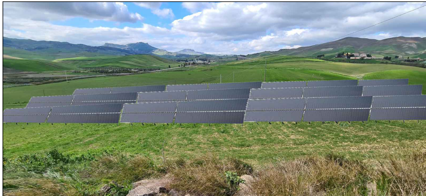
FOTO2: STATO POST OPERAM:
