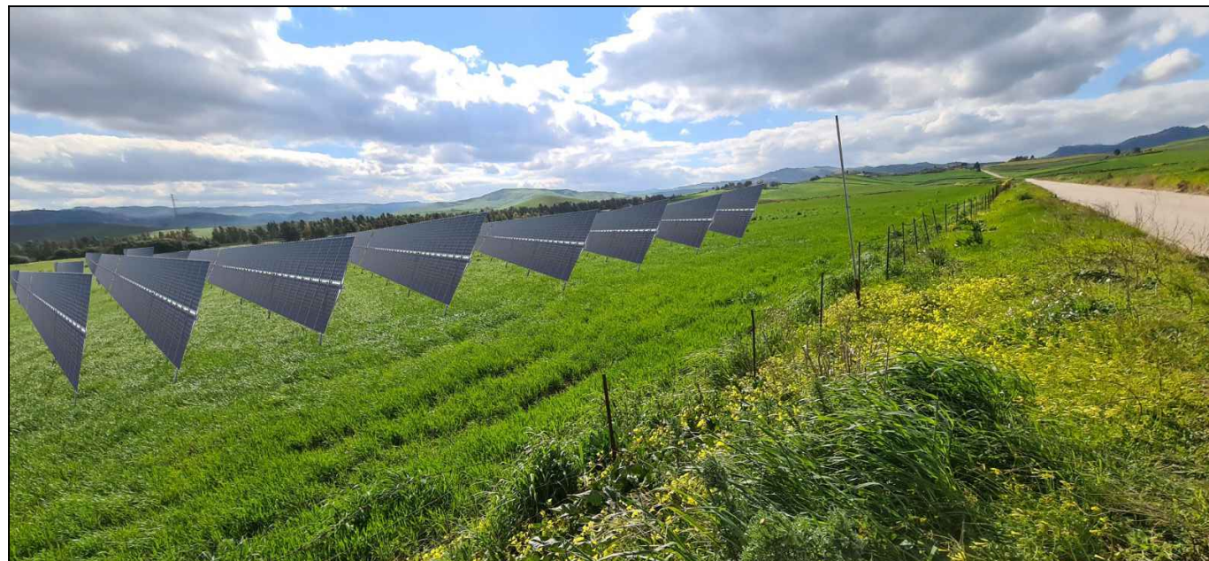
FOTO2: STATO POST OPERAM:
