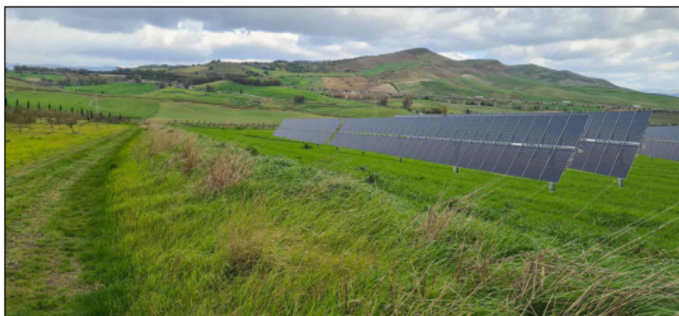
FOTO2: STATO POST OPERAM
