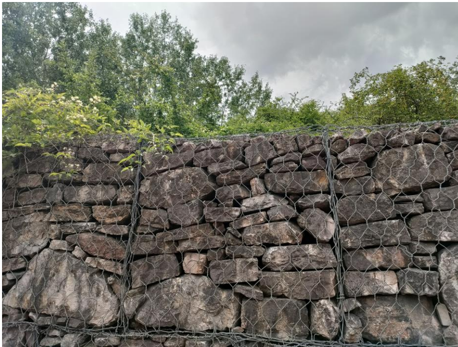
Figura – Muri esistenti lungo la Strada Ospedalone
