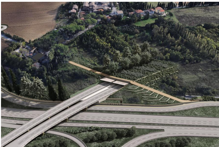
Figura 9.13 – Veduta a volo di uccello dell'imbocco ovest della galleria ferroviaria esistente
