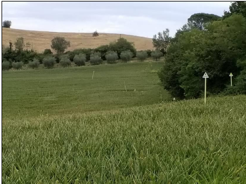
Figura 8.2 Pali segnaletici di una condotta del gas inclinati dall’instabilità gravitativa superficiale lungo il versante esposto a NO della dorsale di Brufa.
