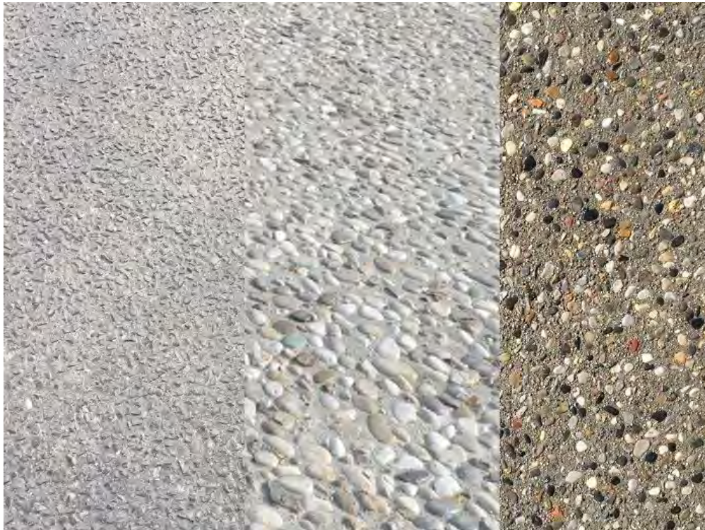
Figura 9.2 – Dettaglio di calcestruzzi lavati con inerte a vista
