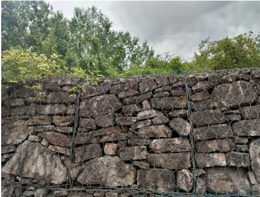
Figura – Muri esistenti lungo la Strada Ospedalone
