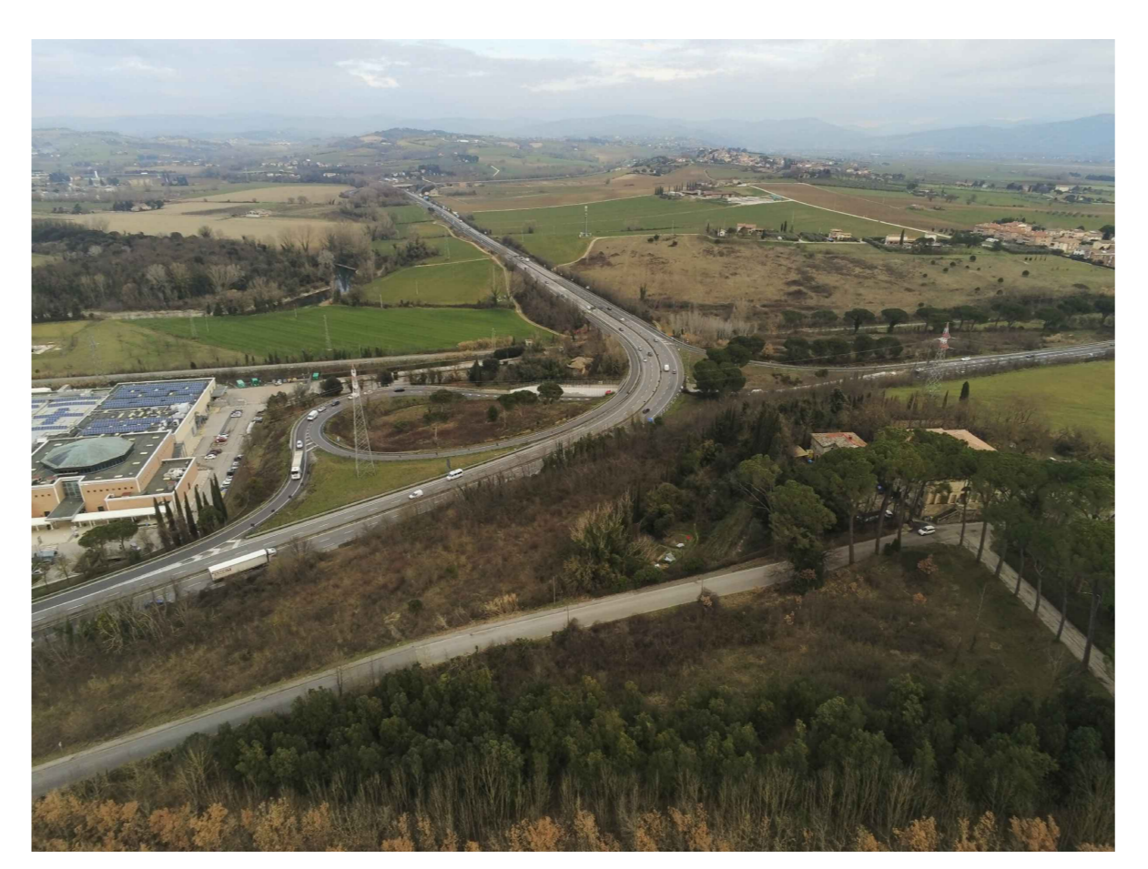
Punto di presa 1 - Svincolo Collestrada
