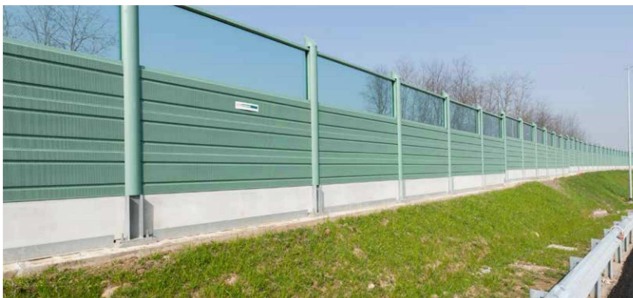
Figura 5.6 Esempio di barriera mista metallica / trasparente
