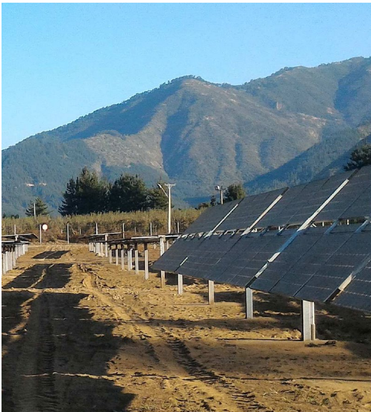
Fig. 6 Disposizione dei moduli fotovoltaici sui tracker
