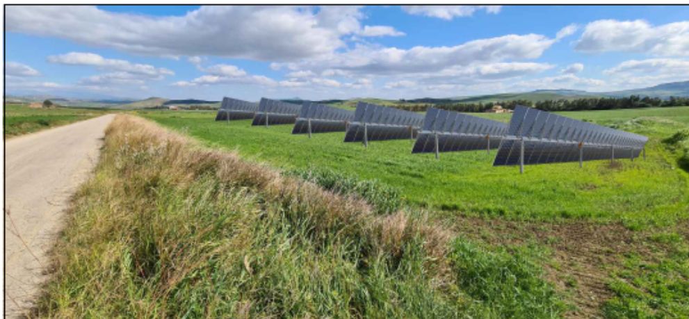
FOTO2: STATO POST OPERAM
