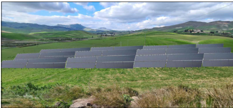
FOTO2: STATO POST OPERAM
