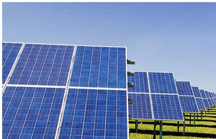
*Figura 19: impianto agrovoltaico con moduli di tipo policristallino*
