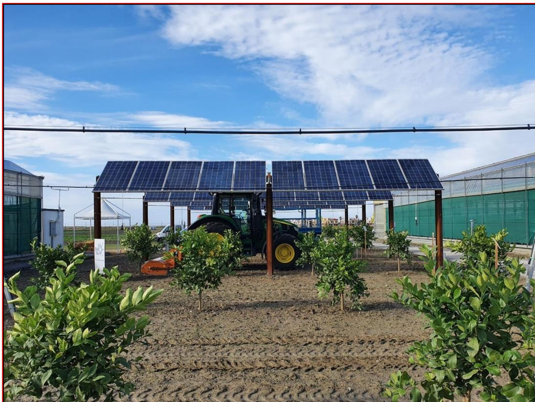
*Figura 3-Inseguitore monoassiale con integrazione fotovoltaica (fonte: Convert Italia)*
