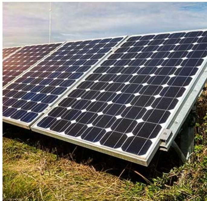
*Figura 18: impianto agrovoltaico con moduli di tipo monocristallino*
