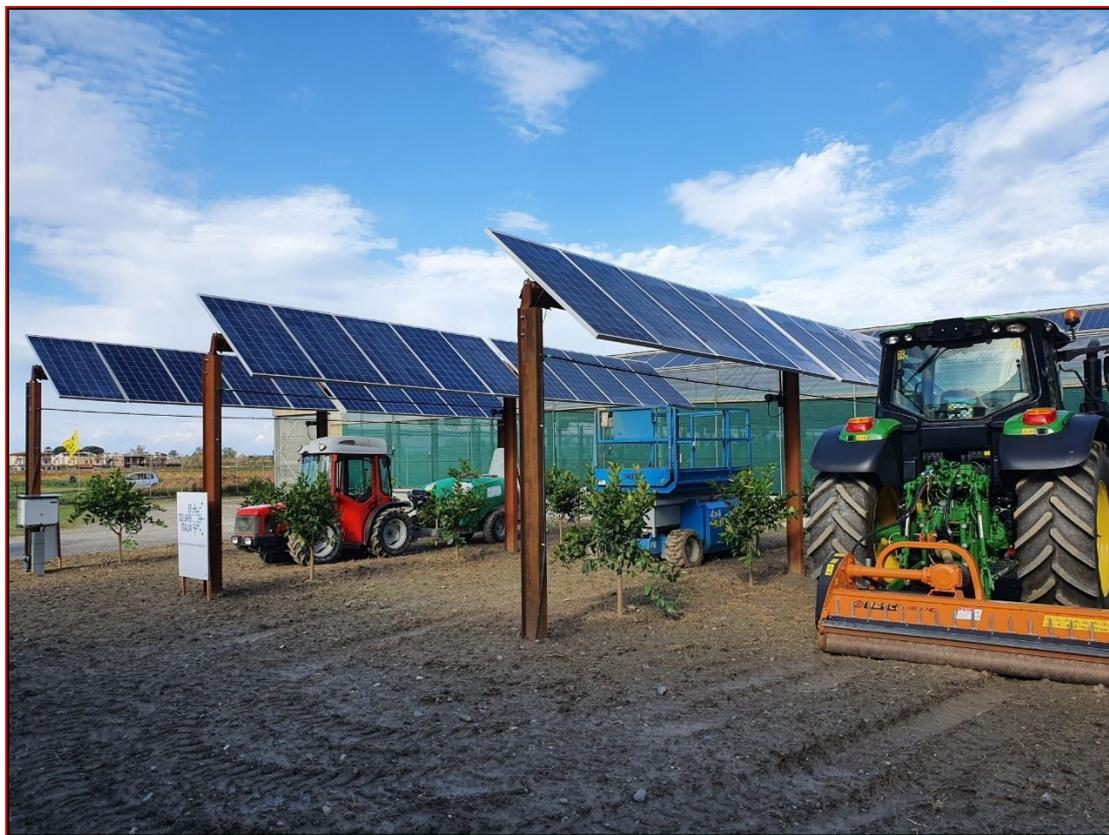
*Figura 4-Inseguitore monoassiale con integrazione agrovoltaica (fonte: Convert Italia)*
