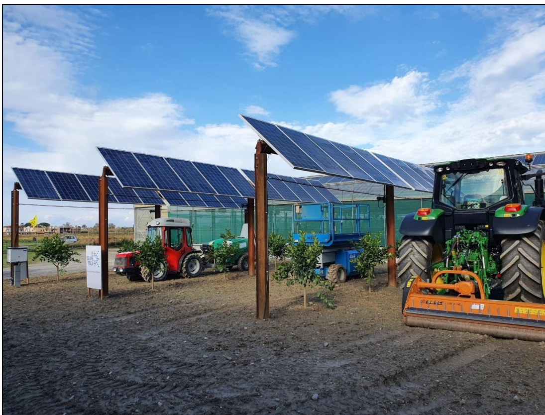
Fig. 1. Inseguitore monoassiale con integrazione agro-voltaica (fonte: Convert Italia).
