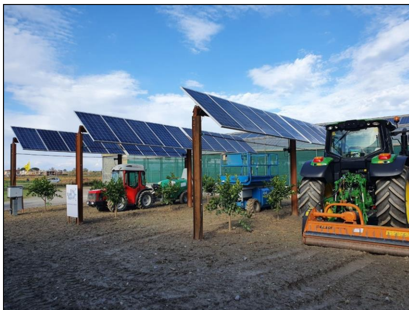
Figura 2. Inseguitore monoassiale con integrazione agro-voltaica (fonte: Convert Italia).
