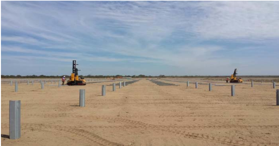
Figura 8 – Posa tipologica della struttura di sostegno del modulo fotovoltaico
