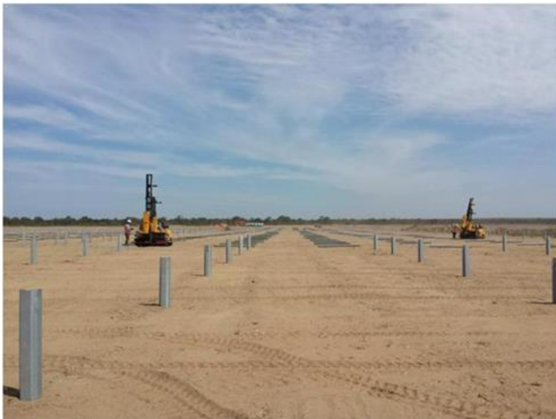
Figura 3.8 Fase di infissione dei pali in acciaio zincato (fonte Convert)
