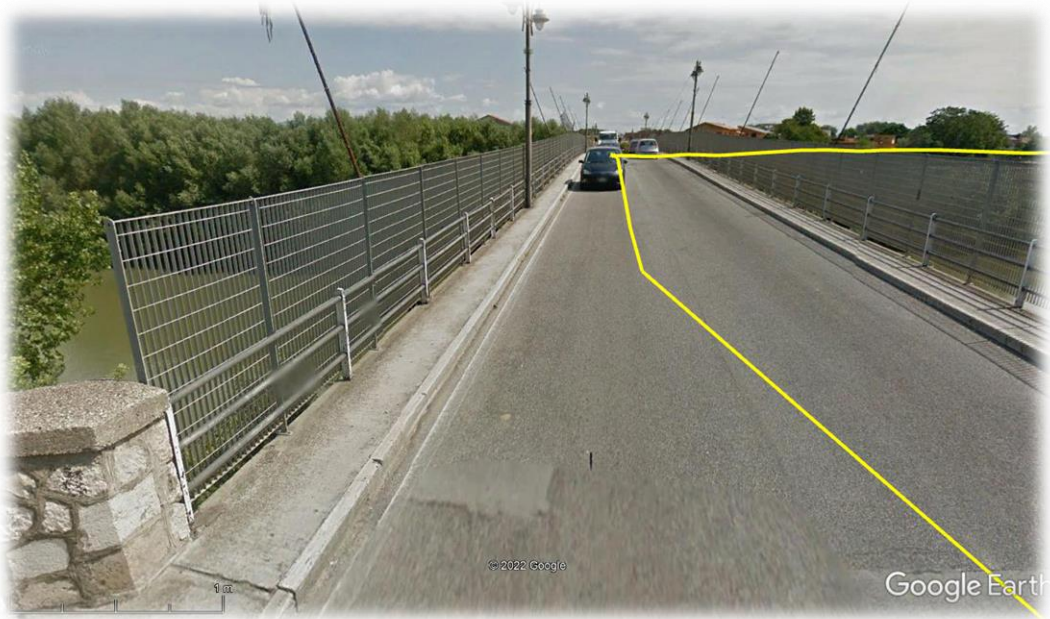
Figura 15. Dettaglio percorso cavidotto MT in posizione 41°04'28.42"N 14°01'41.12"E
