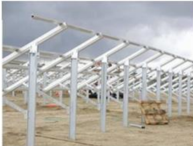
Fig. 2 Strutture di sostegno moduli completamente riciclabile e facilmente estraibili dal suolo in fase di dismissione.
