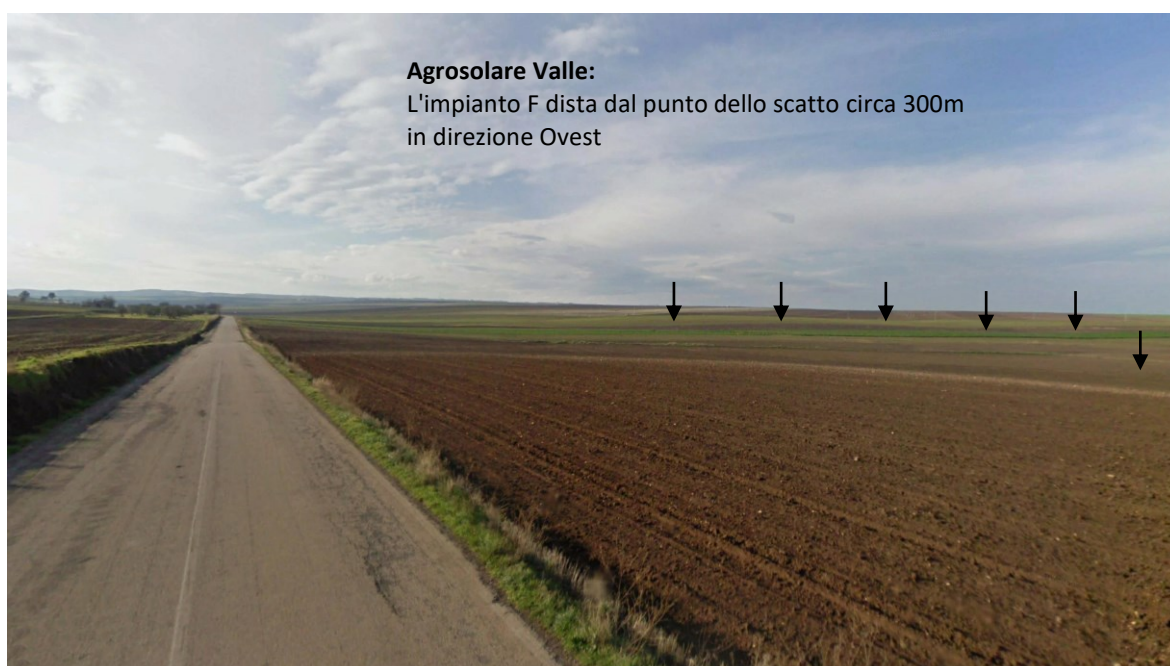
Figura 20 – foto dal punto F verso l'impianto F
