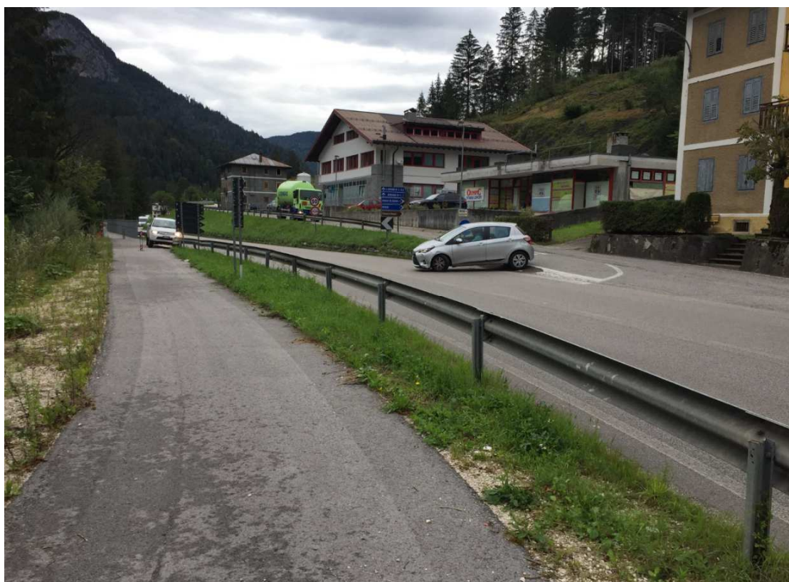
Figura 6 – Documentazione fotografica Stato di Fatto
