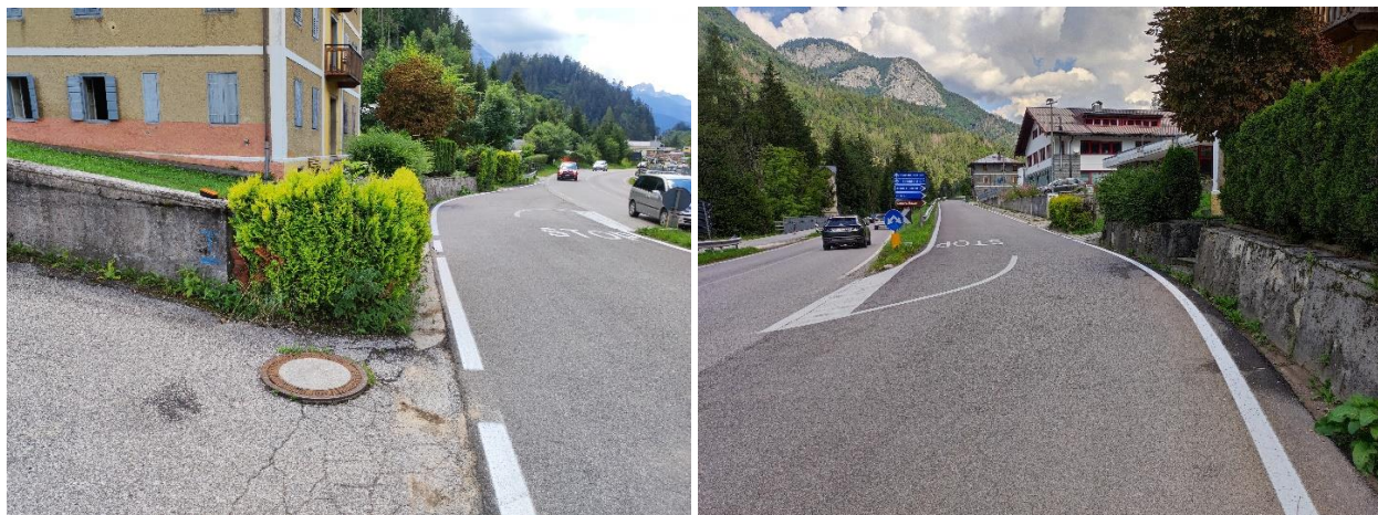
Figura 3 e Figura 4 – Stato di Fatto – Scatti 1 e 2
