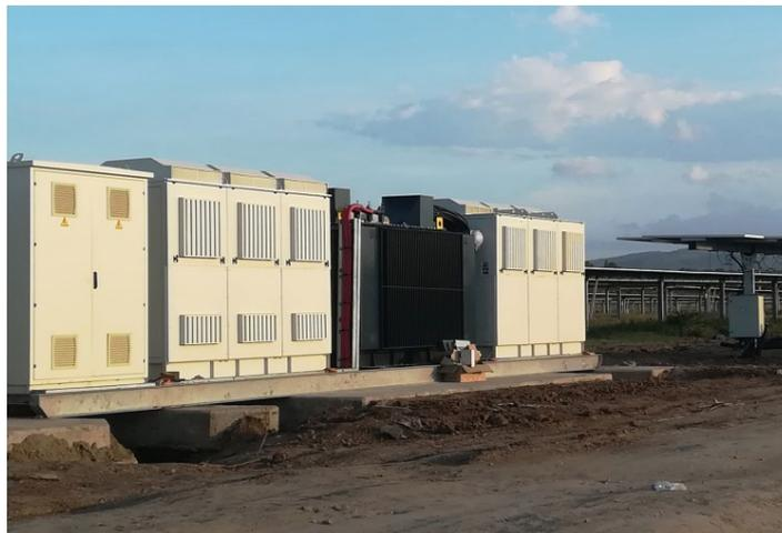
Figura 10 Esempio skid conversione
