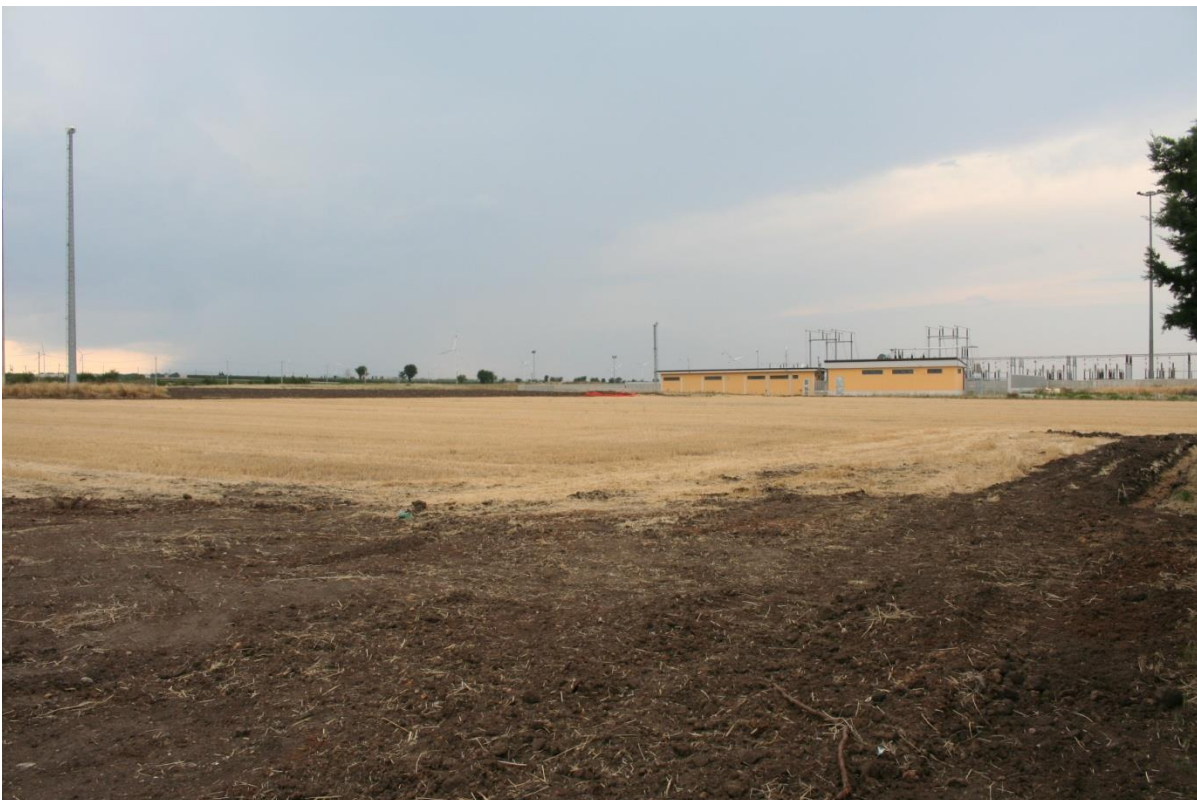
16- Ascoli Satriano (FG) UR 2 ultimo segmento di cavidotto, panoramica in direzione NO
