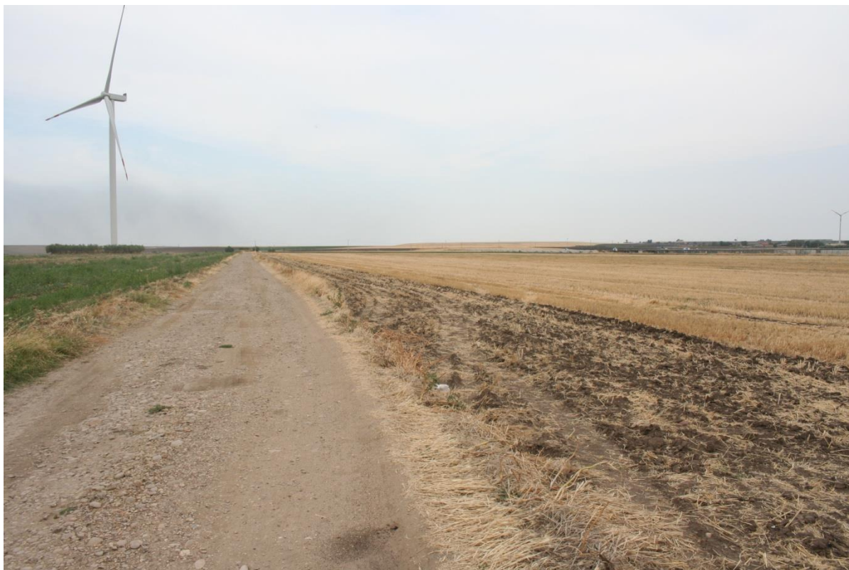
13- Ascoli Satriano (FG) Piscitello di Sopra UR 2, panoramica del segmento di cavidotto in direzione E
